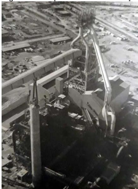
Figura 25 – Açominas em construção
