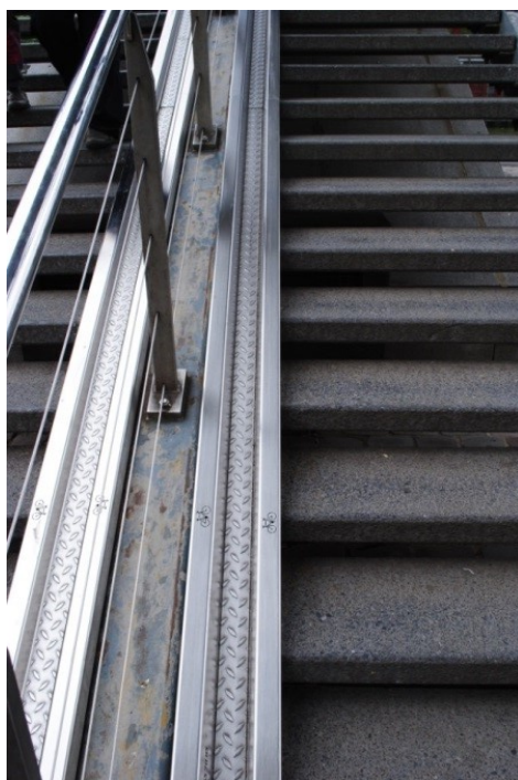
Figura 26 - Rampa lateral à escada para circulação de bicicleta.
