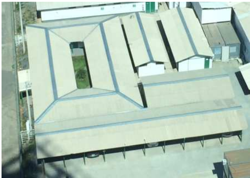
Figura 15 – Vista aérea de elemento de apoio de um Canteiro de Obra.
