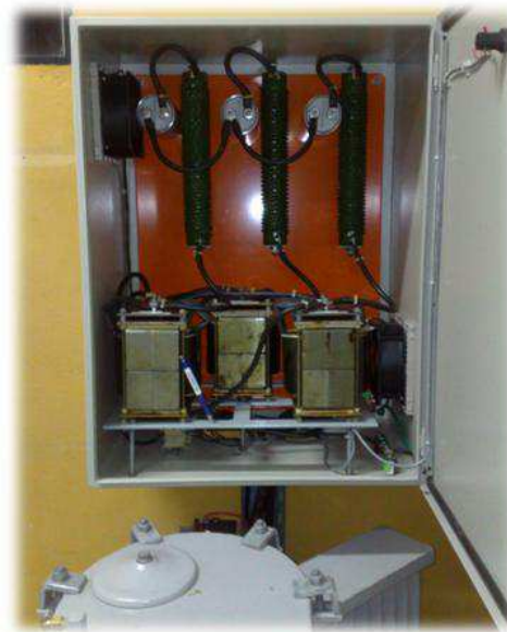
Figura 3.4: Fotografia do Filtro LC Construído
