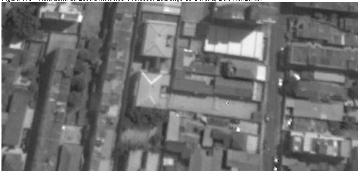
Figura 170 - Vista aérea da Escola Municipal Professor Lourenço de Oliveira, Belo Horizonte.
