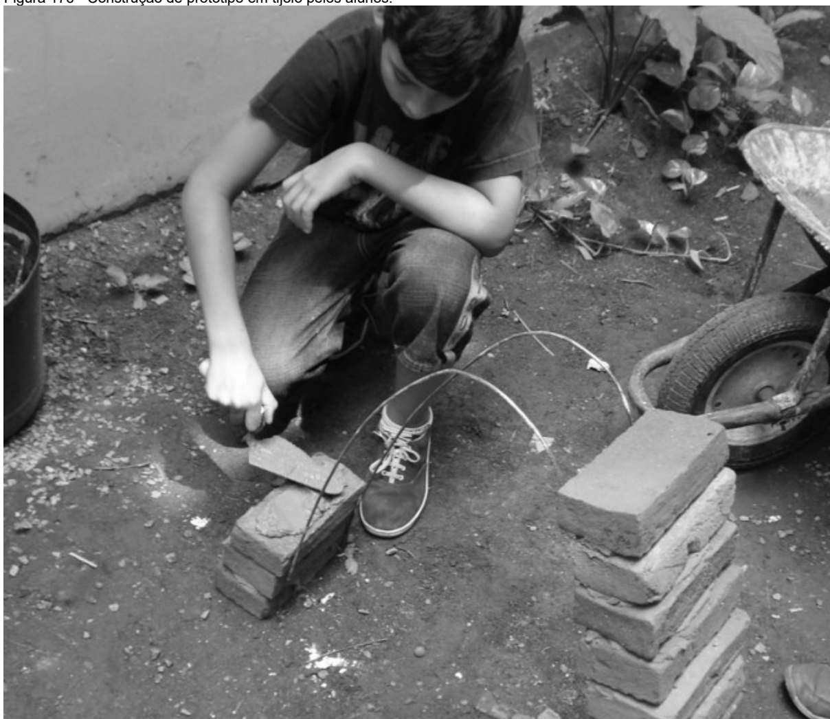
Figura 176 - Construção de protótipo em tijolo pelos alunos.
