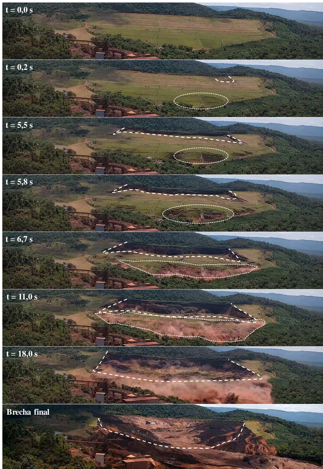
Figura 9 – Ruptura da Barragem B1 Córrego do Feijão
