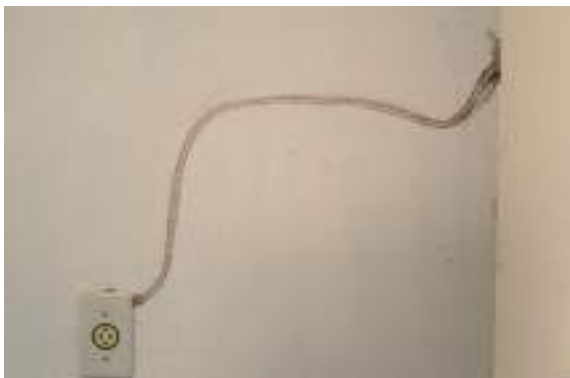
Imagem 44 - Detalhe do acesso de entrada dos cupins pela instalação elétrica do prédio. Marcas na parede da passagem construída da tomada elétrica na parte inferior da parede ao canto da sala onde se posicionava o mobiliário de armazenamento das coleções em Reserva Técnica. Crédito de imagem: Mônica Lima de Carvalho.
