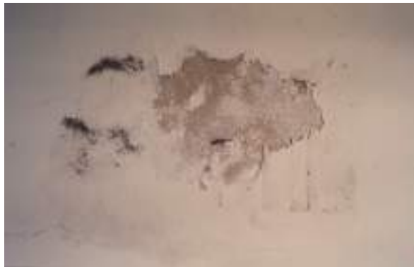
Imagem 44 - Detalhe do acesso de entrada dos cupins pela instalação elétrica do prédio. Marcas na parede da passagem construída da tomada elétrica na parte inferior da parede ao canto da sala onde se posicionava o mobiliário de armazenamento das coleções em Reserva Técnica. Crédito de imagem: Mônica Lima de Carvalho.
