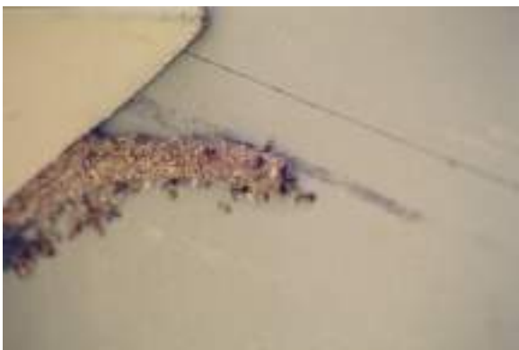
Imagem 42 - Detalhe do conduto de acesso do solo para a vitrine localizada na sala de exposição “Museu: Expressão de Vida”, construído pelos cupins.
