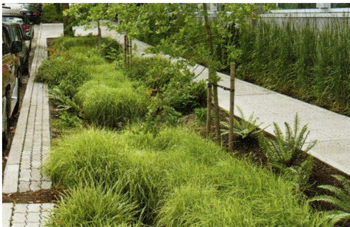
Figura 19 - Valeta de biorretenção na faixa de mobiliário urbano
