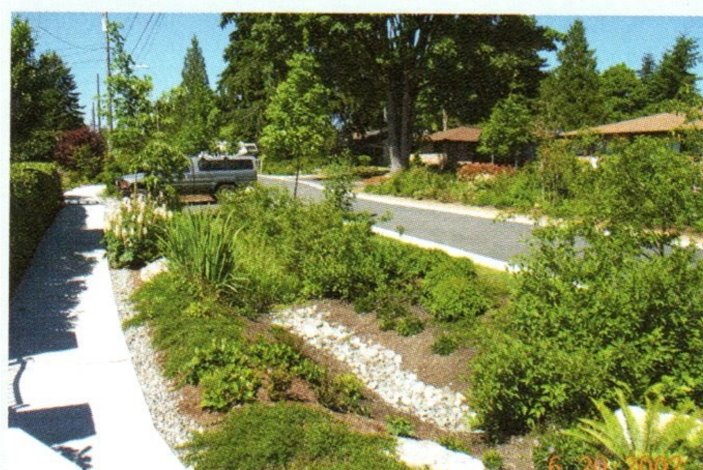
Figura 6 - Vala, ou valeta, de biorretenção
