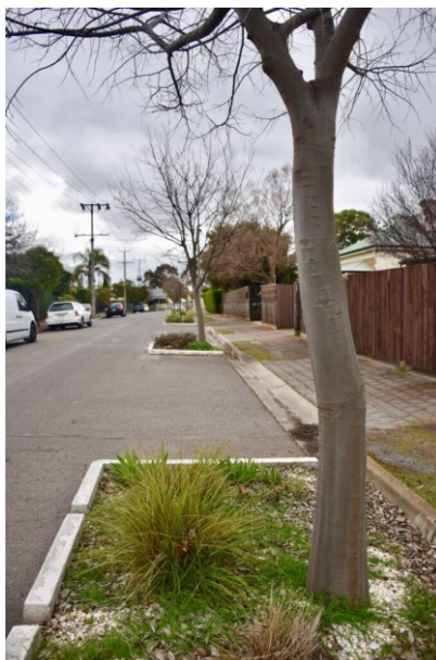
Figura 29 - Um dos jardins de chuva instalados na Pollock Avenue, na Região Metropolitana de Adelaide
