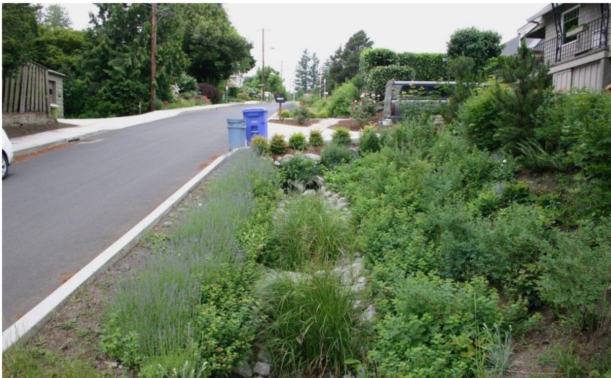
Figura 20 - Vala de biorretenção em Portland
