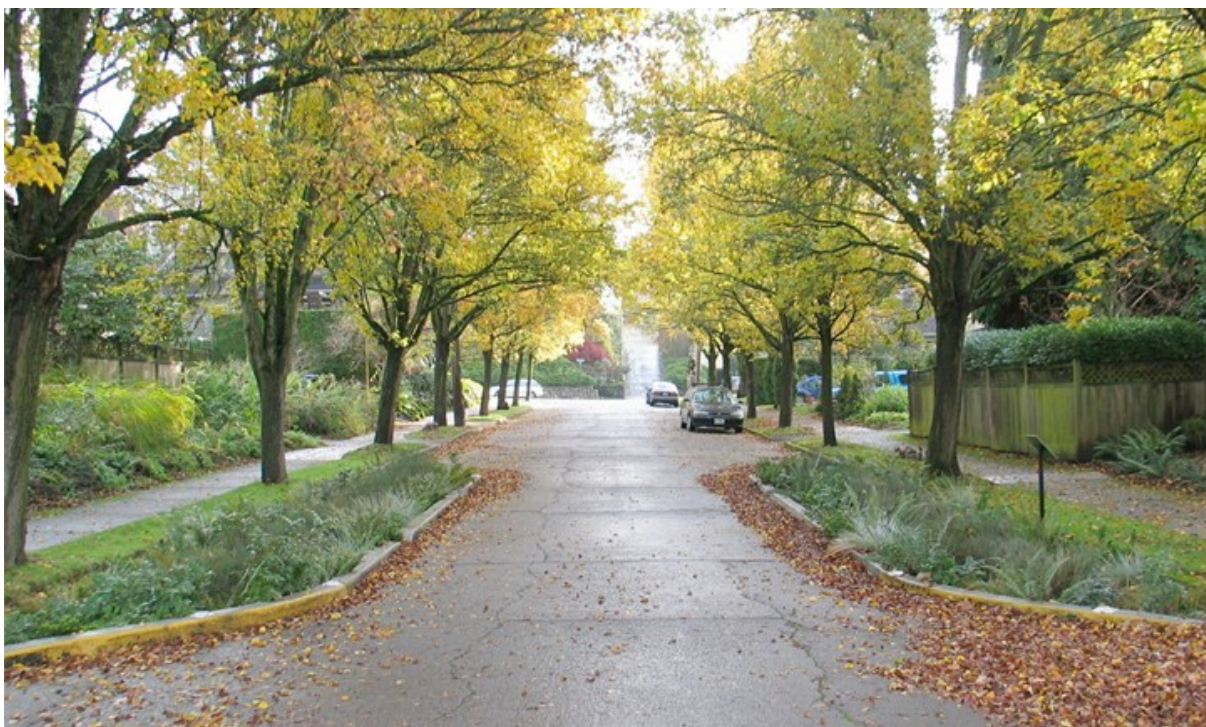
Figura 25 - Jardins de chuva instalados em extensões do meio-fio da Rua Verde NE Siskiyou
