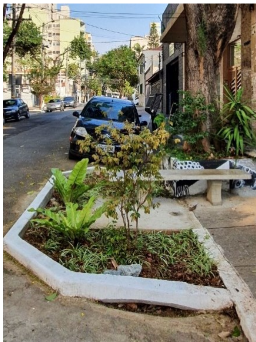
Figura 16 – Vaga verde (jardim de chuva em vaga de estacionamento) construída em rua em São Paulo
