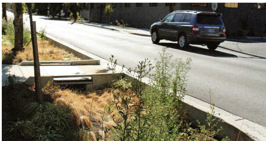
Figura 23 - Canteiro híbrido de biorretenção
