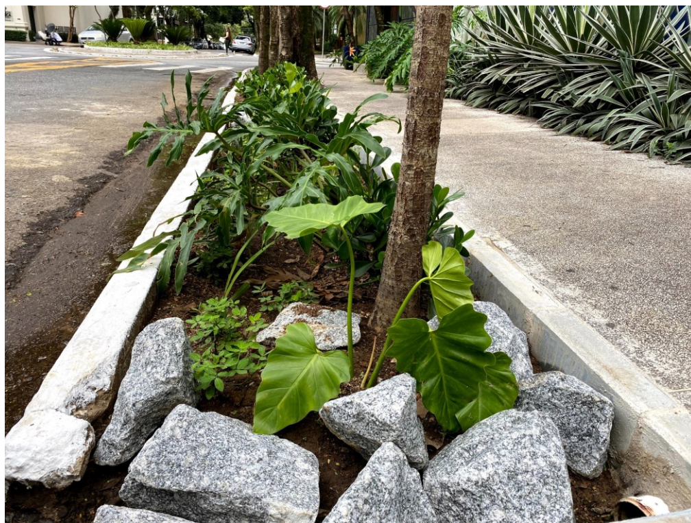
Figura 7 - Canteiro (jardim de chuva) no bairro Vila Mariana, em São Paulo
