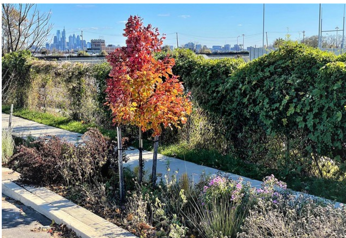
Figura 26 - Biovaleta que recebe as águas pluviais da rua que são direcionadas para a calçada
