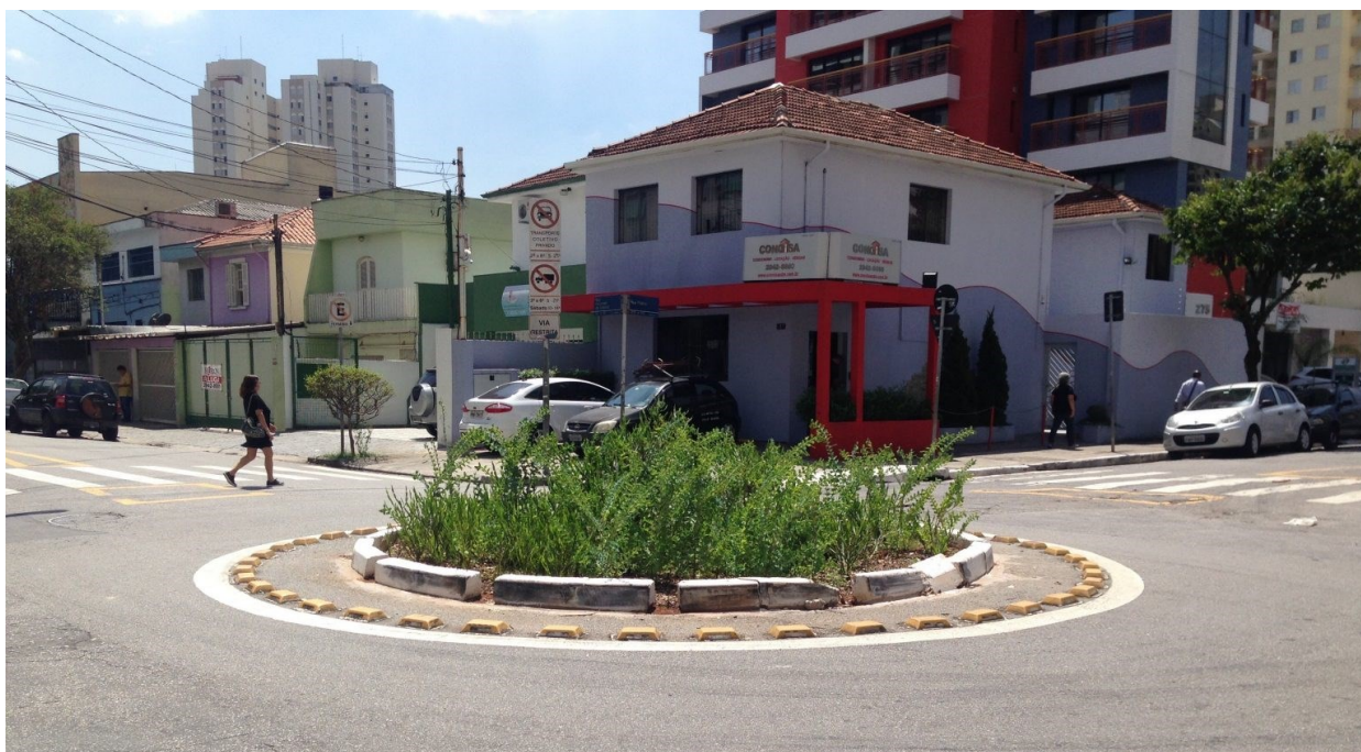
Figura 8 - Jardim de chuva construído em rotatória no bairro do Tatuapé, em São Paulo
