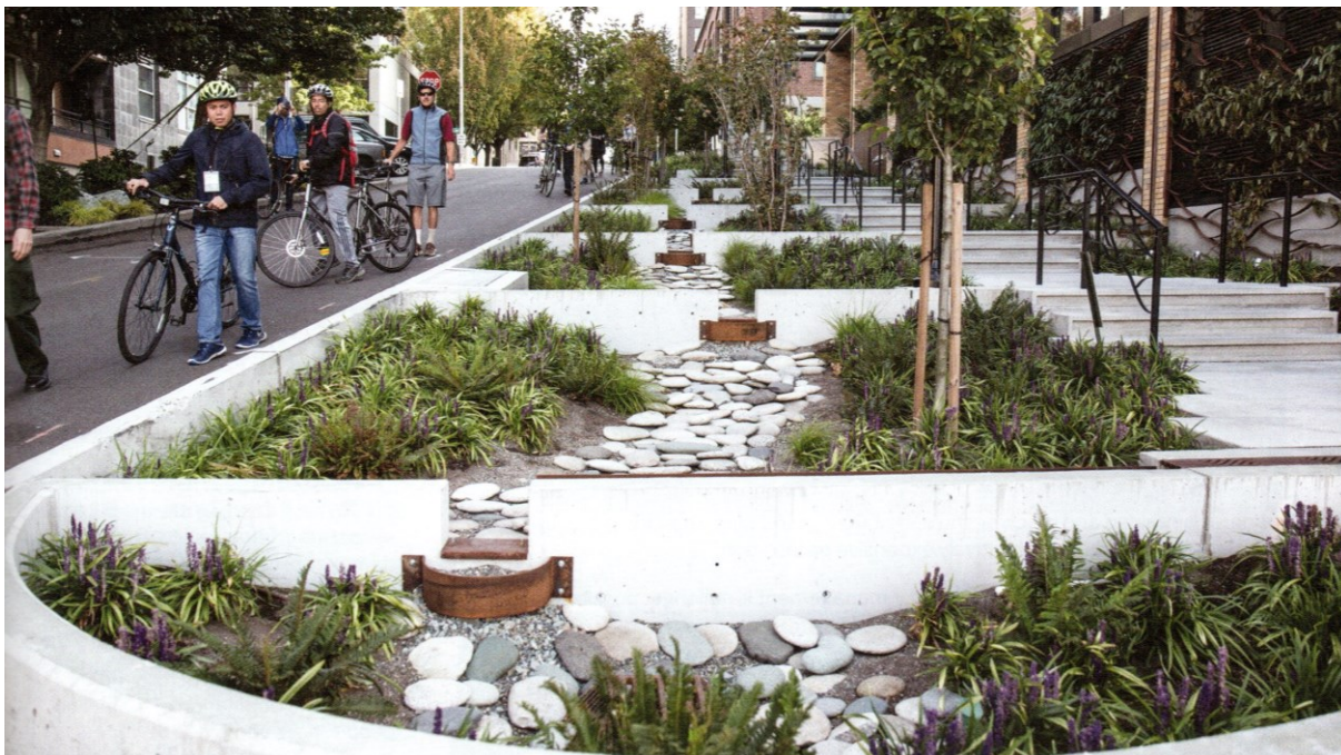
Figura 21 - Vala de biorretenção em via com declividade
