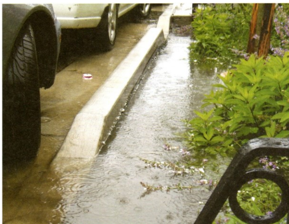
Figura 3 - Canteiro de biorretenção em calçada
