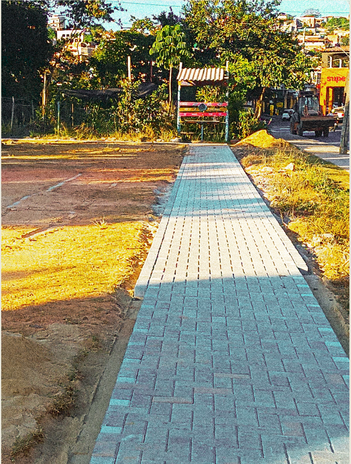
Figura 34. Construção da pista de caminhada do parque ciliar comunitário do Ribeirão Onça, referente ao Prêmio ONU-Habitat 2019, ago. 2023.
