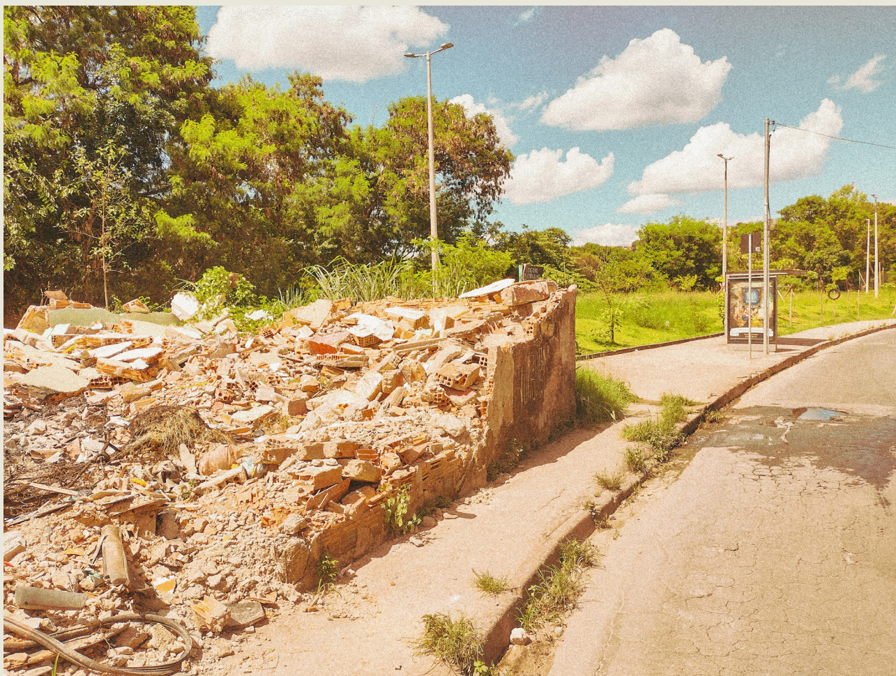
Figura 27. Última casa demolida na Rua Antônio Ribeiro de Abreu, 2022.
