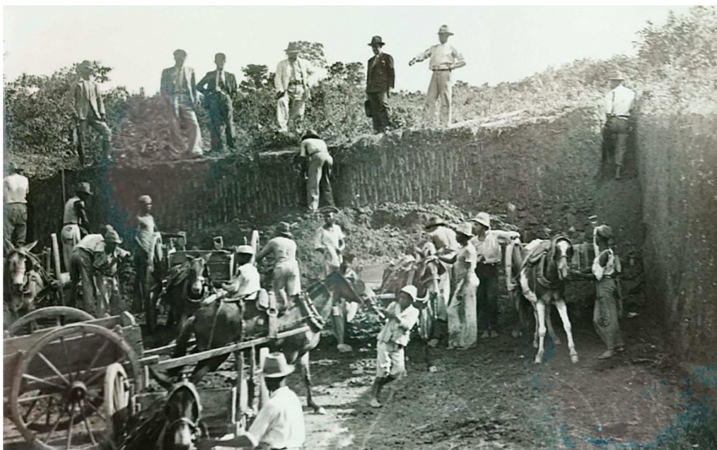
Figura 4. Serviço de terraplanagem e abertura de ruas. (Arquivo fotográfico da Cidade Ozanam - 1937)
