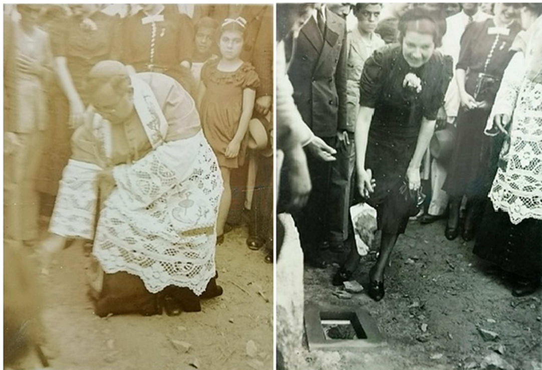
Figura 10. Dom Cabral e Odete Valares colocam as primeiras pás de cimento. (Arquivo Fotográfico da Cidade Ozanam - 1937).
