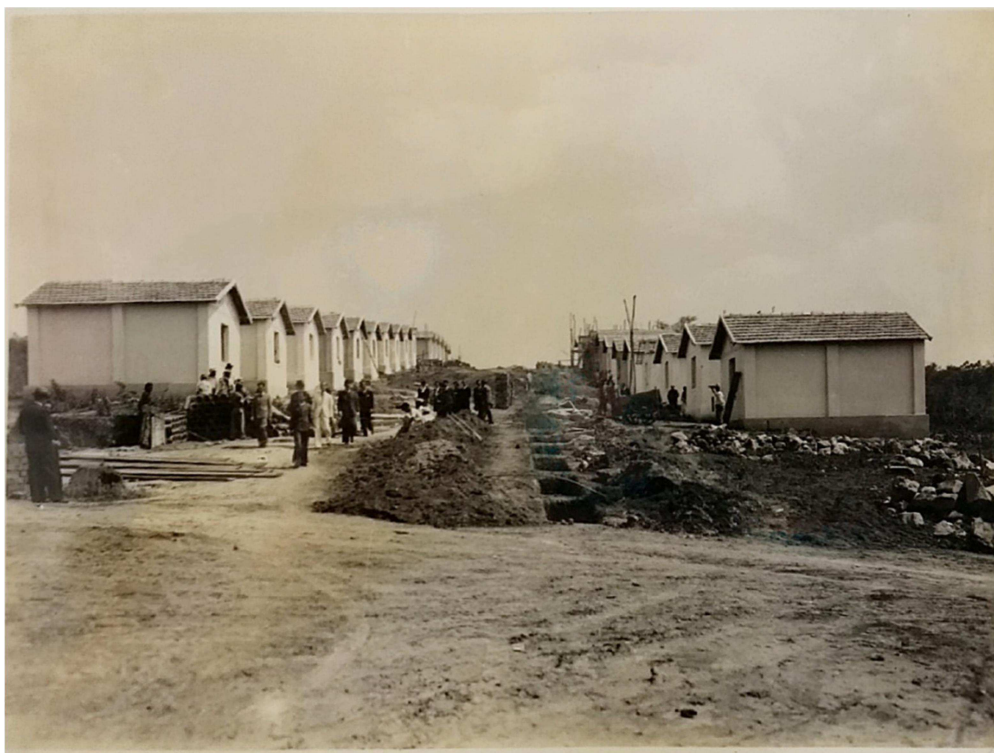
Figura 5. Instalação da rede de esgoto. (Arquivo fotográfico da Cidade Ozanam - 1937)
