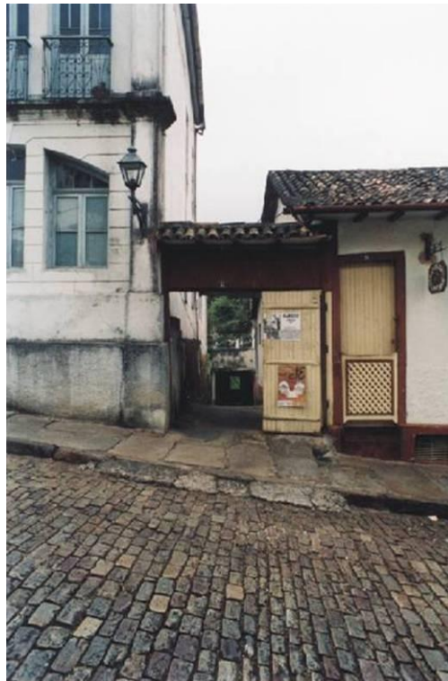
Figura 20 Aspecto do acesso ao Vale dos Contos pelo Pilar, antes da intervenção
