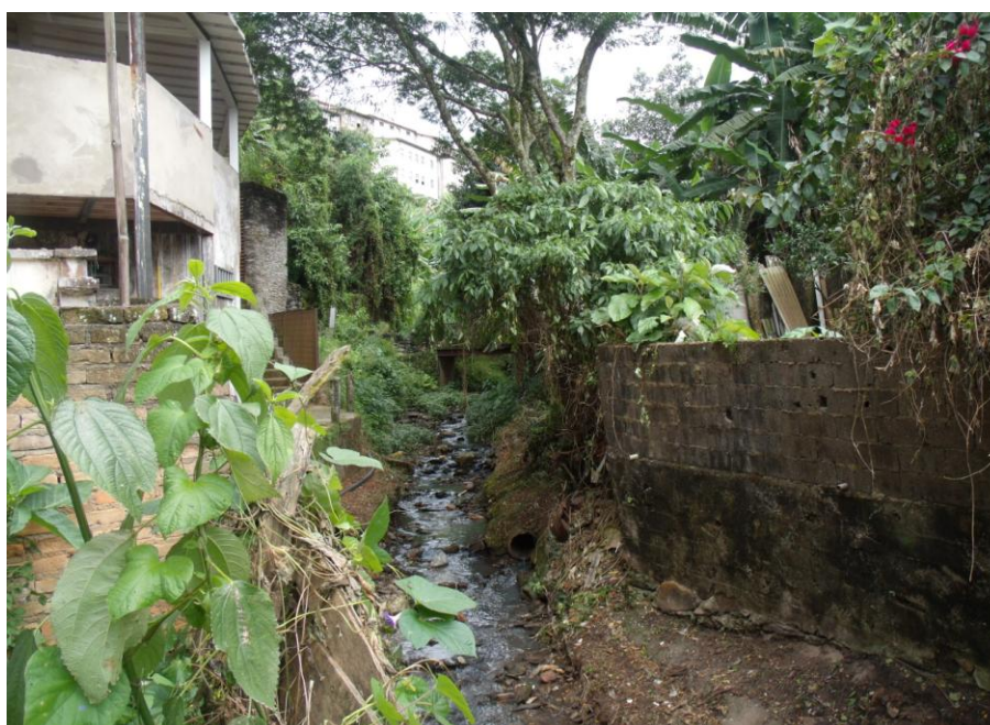
Figura 79 À esquerda, imóvel em reformas, com o lance de escadas construído pela moradora em segundo plano. Nesse trecho, ainda há lançamento de esgoto no Córrego dos Contos
