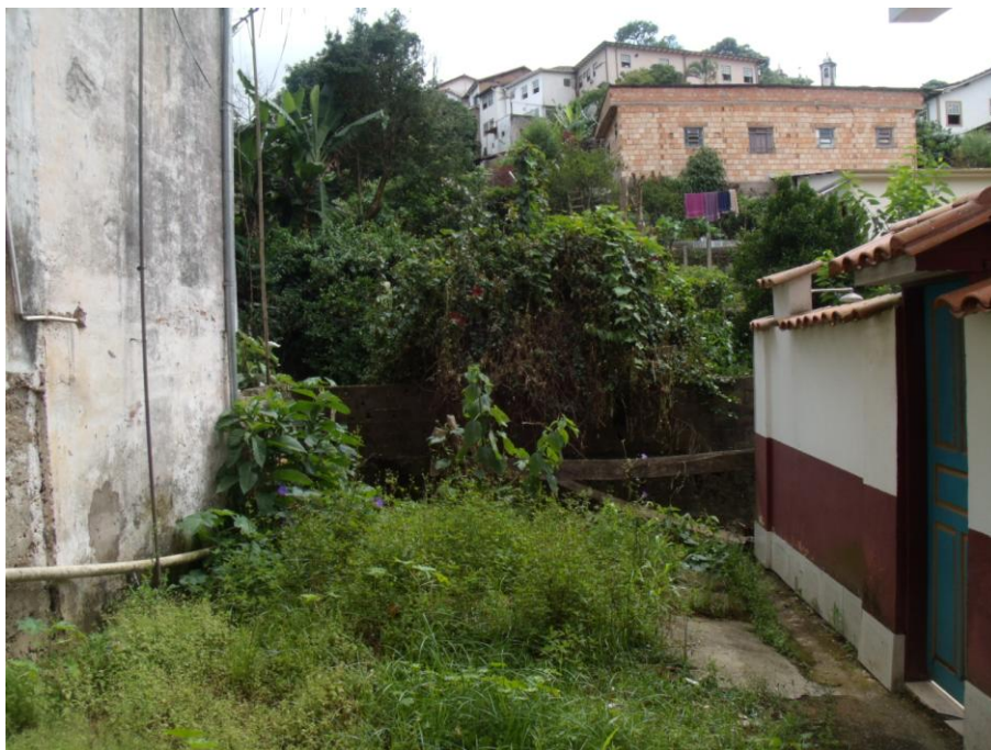
Figura 80 Aspecto do quintal da edificação I, que perdeu suas funções originais
