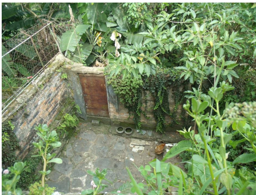
Figura 84 Parte baixa do quintal da edificação III, na cota do Parque
