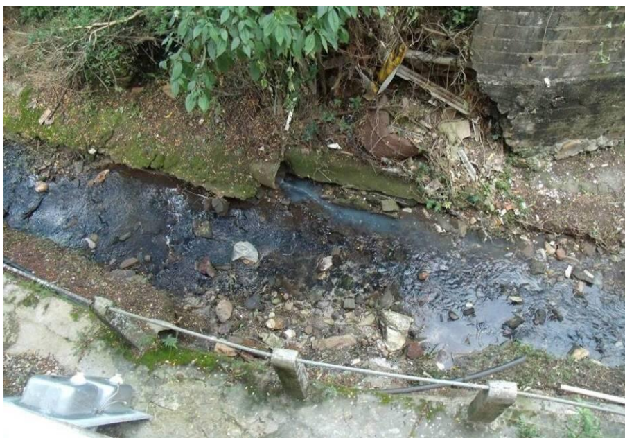
Figura 11 Tubulação lançando esgoto diretamente no Córrego, próximo à portaria do Pilar
