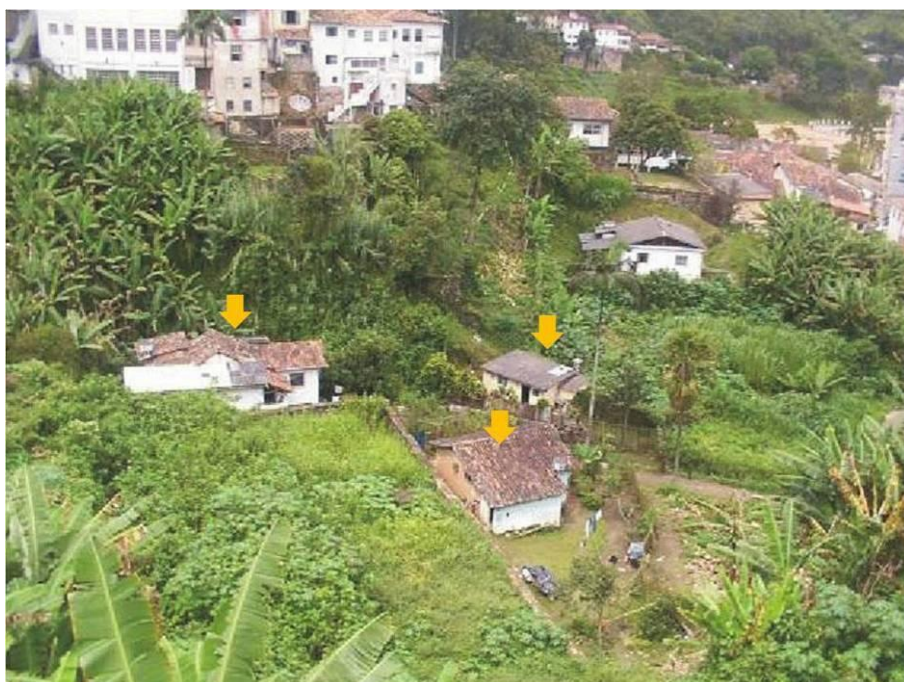
Figura 10 Os três imóveis demolidos no Vale dos Contos
