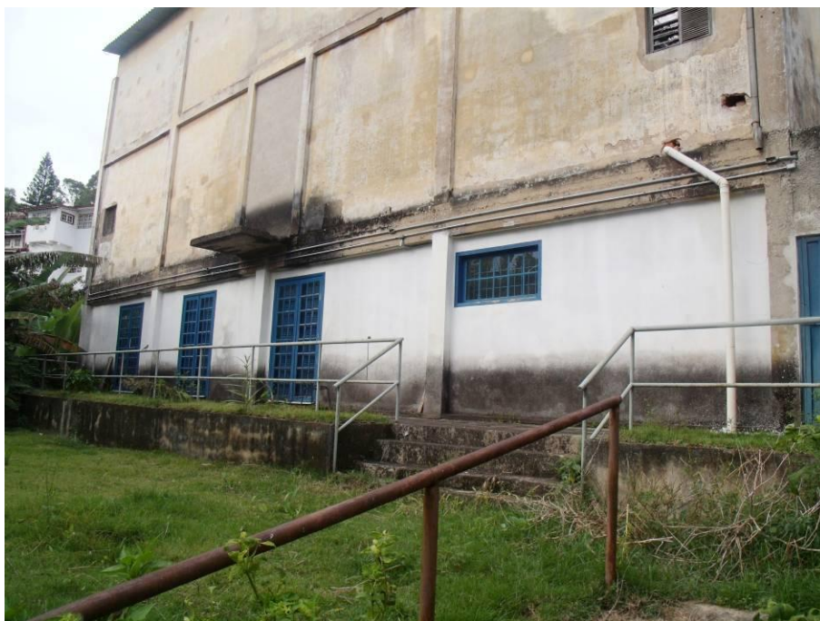
Figura 14 Acesso ao porão do Cine Vila Rica, sob a sala de projeção. O espaço para a prática de tai chi chuan , previsto em projeto, não pôde ser implantado
