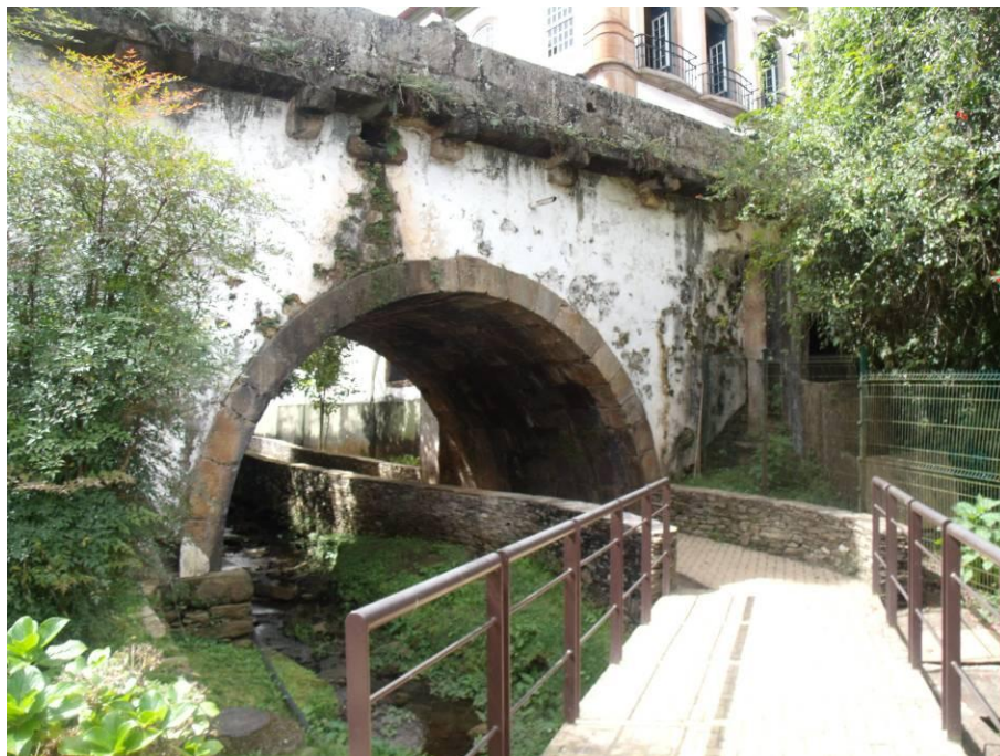
Figura 24 Ponte de conexão entre Horto e Vale e passagem sob a Ponte dos Contos. Ao fundo, trilha implantada ao lado da Casa dos Contos
