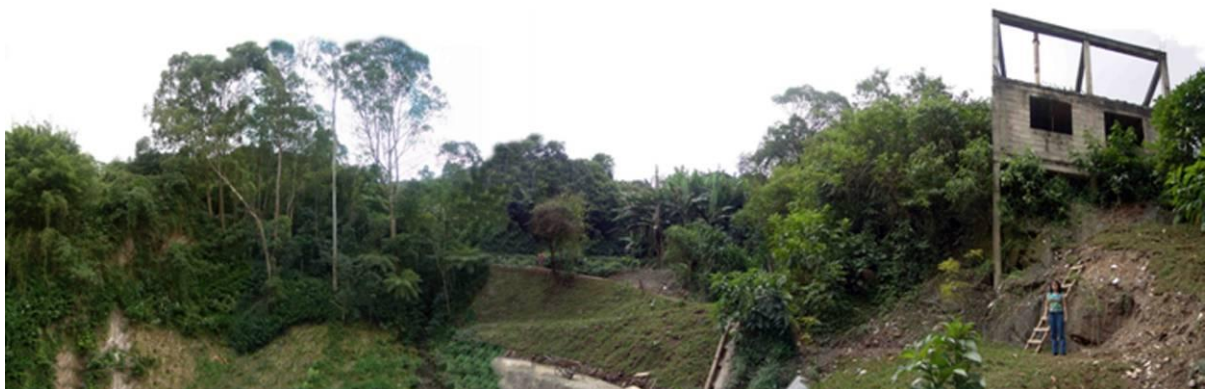
Figura 15 Aspecto geral do anexo ao Grande Hotel de Ouro Preto, onde funcionava a caldeiraria
