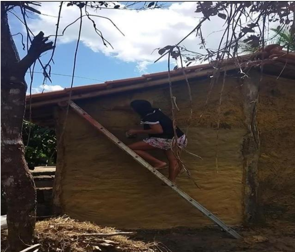
(Fonte: Naktã Pataxó, 2023, paredes sendo alisadas)
