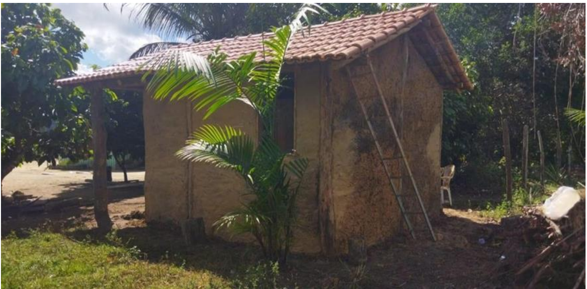
(Fonte: Naktã Pataxó, 2023, paredes sendo alisadas)
