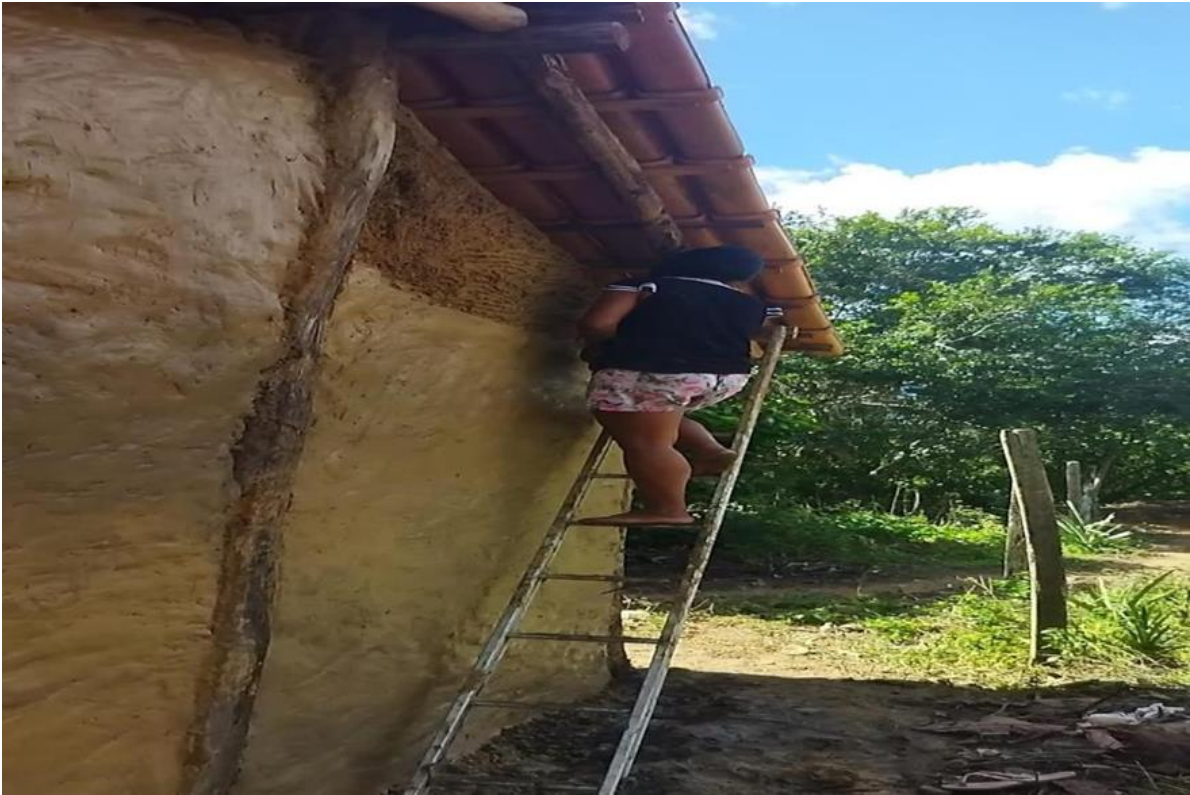
(Fonte: Naktã Pataxó, 2023, paredes sendo alisadas)
