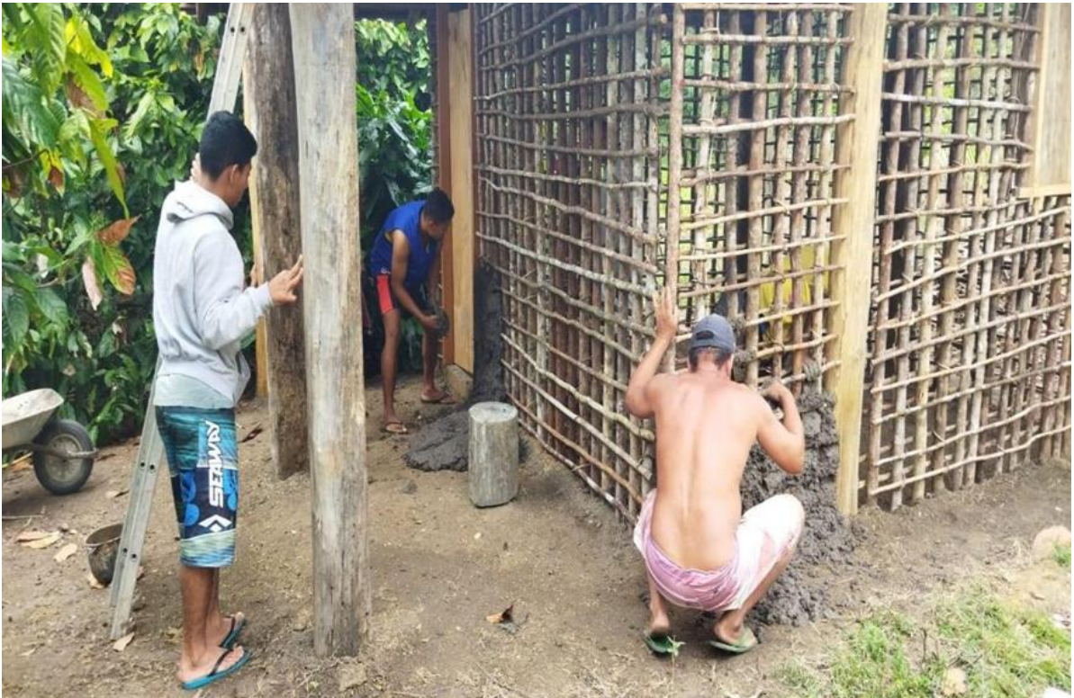
(Fonte: Naktã Pataxó, 2023, primeiras paredes embarreadas)
