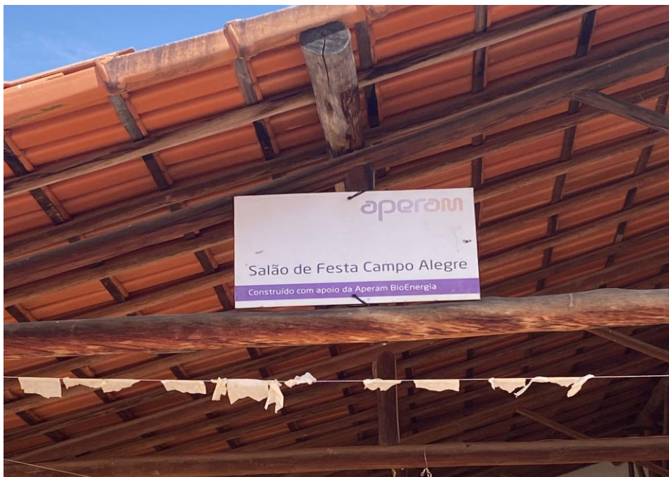
Imagem 7: Publicidade da Aperam na placa do salão de festa da comunidade Campo Alegre, Turmalina/MG, construído com apoio da Fundação Aperam Acesita.
