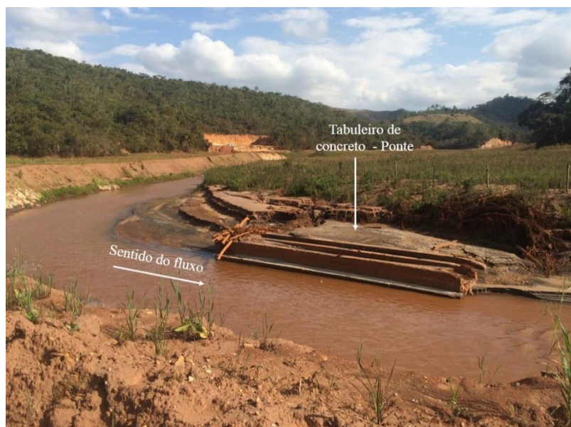
Figura 4.19 – Detritos arrastados pelo vale do rio, tabuleiro de concreto de ponte (Foto tirada na visita do dia 20/07/2016)
