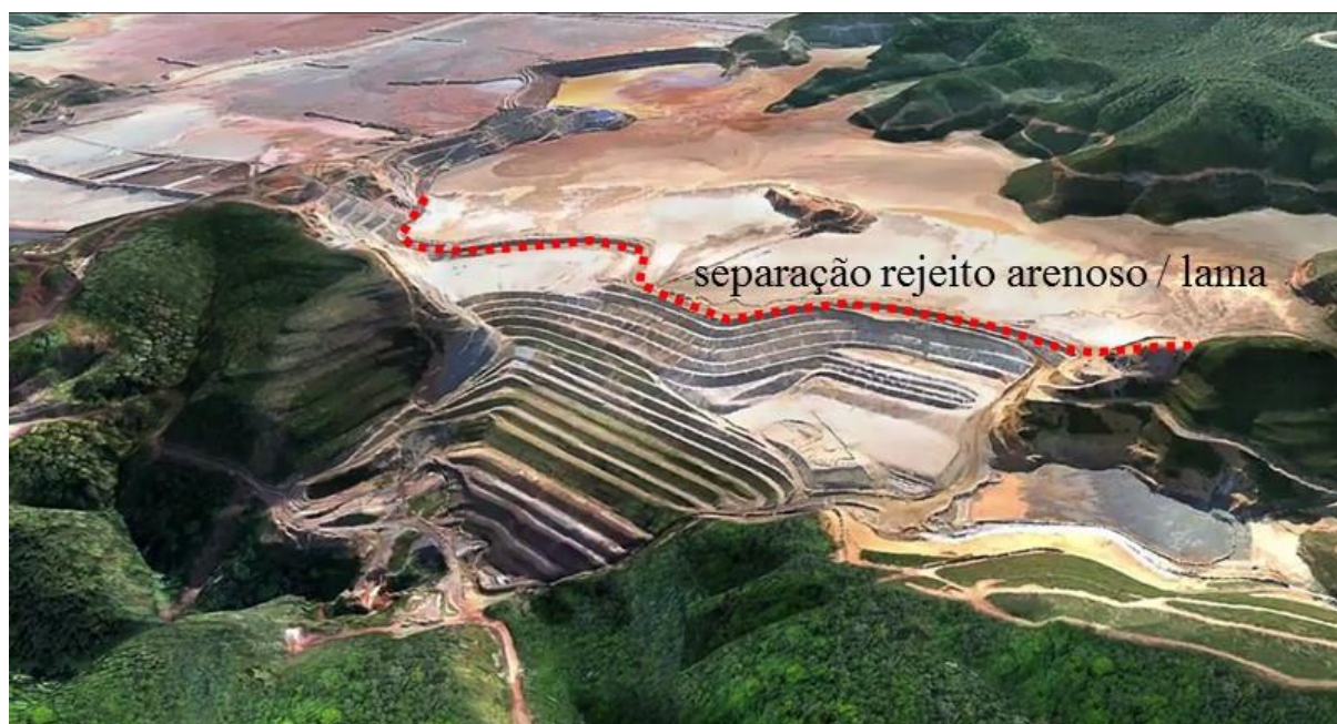
Figura 1.1 – Imagem aérea da Barragem do Fundão
