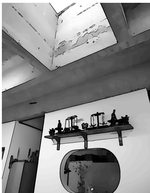
Imagem que detalha o teto de vidro
