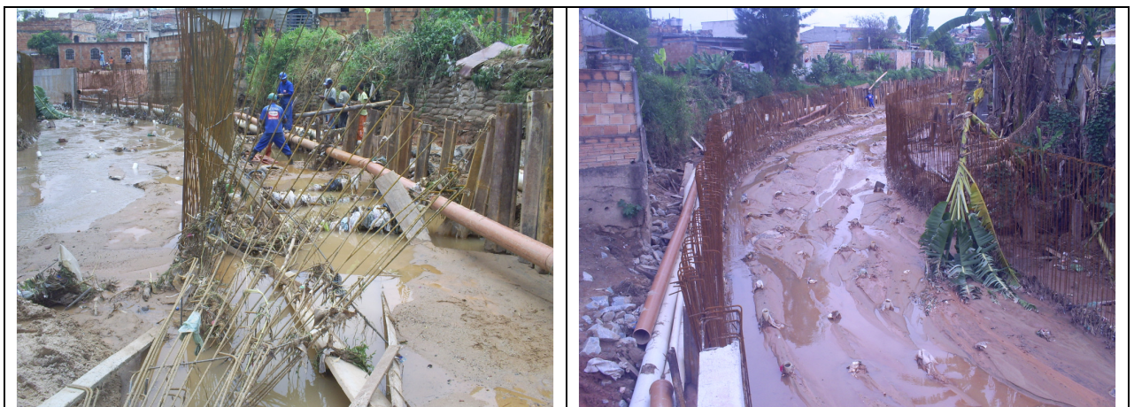
Figura 34 – Trecho de obra entre estacas E73 e E80 – Caso 01.
