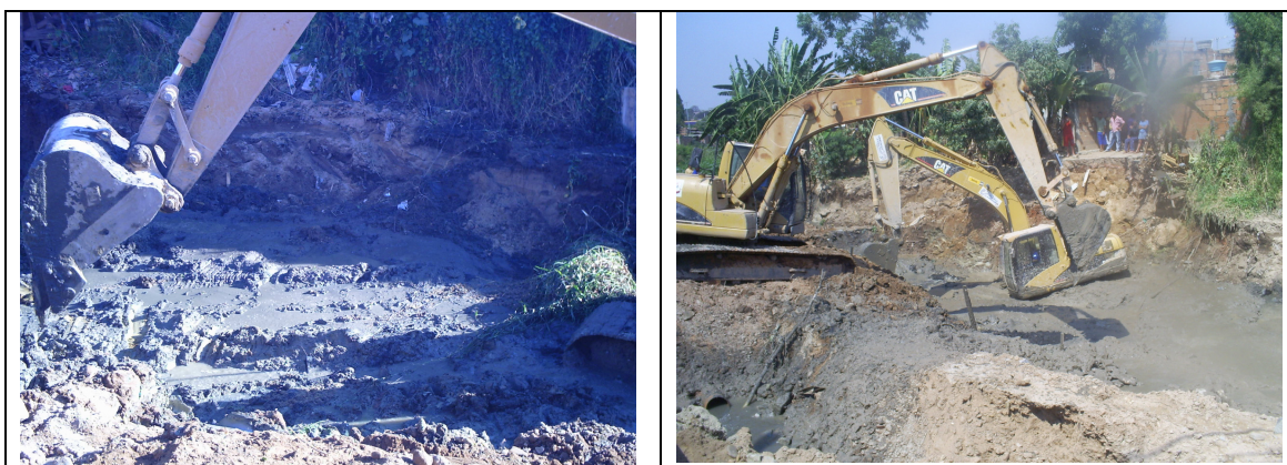
Figura 22 – Caso 02. Vista do material e da dificuldade de se trabalhar com o mesmo no leito do córrego.
