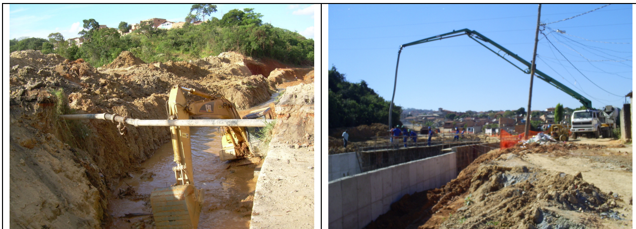
Figura 23 – Adutora existente na estaca E95+7,0, à esquerda. Bombeamento e poste de energia elétrica, à direita
