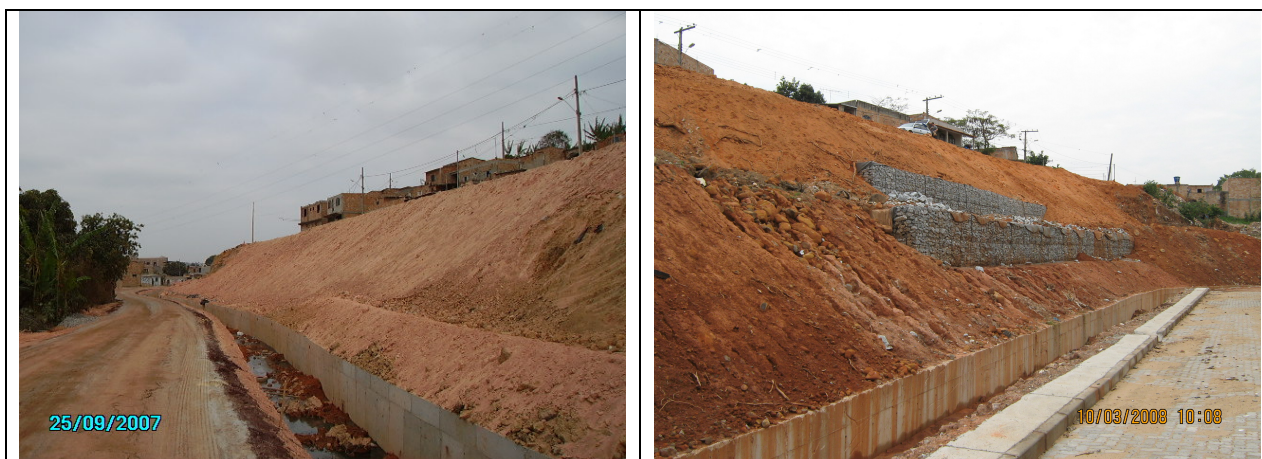
Figura 31 – Estado das encostas após a execução do gabião e do aterro mecanizado.
