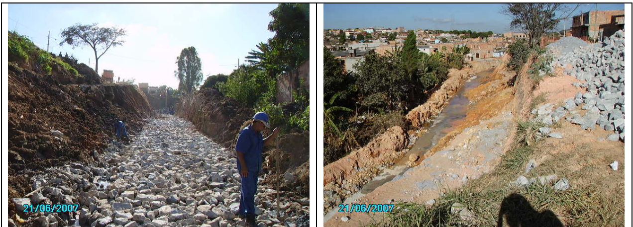
Figura 48 – Enrocamento com pedra de mão. À esquerda, já lançado. À direita, estocado, fora do local de aplicação.
