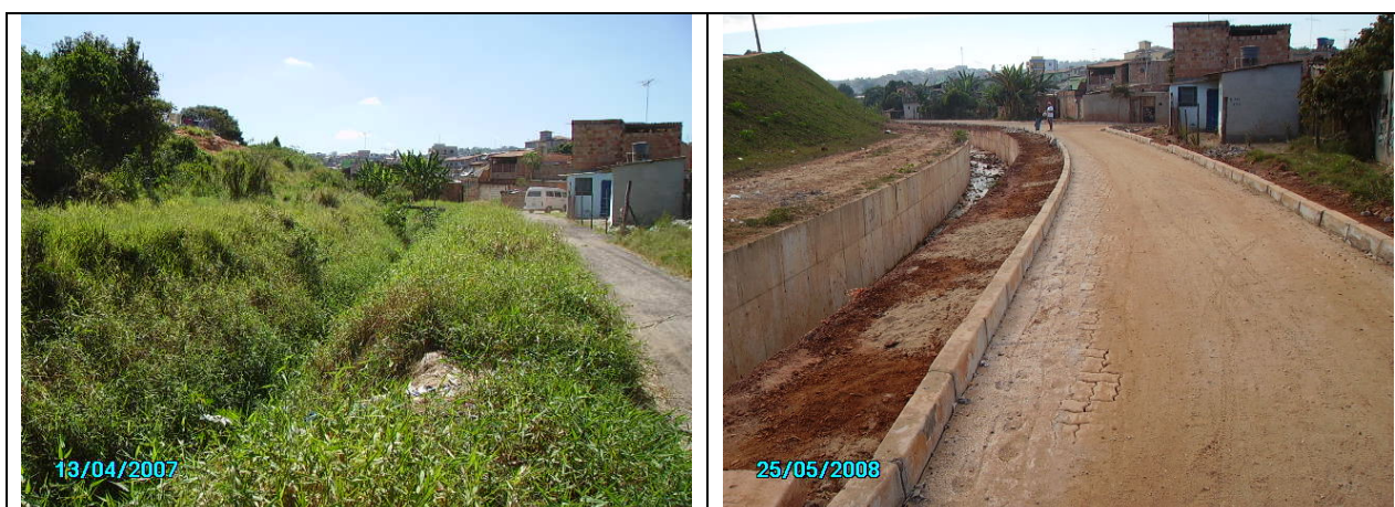
Figura 18 – Trecho entre estacas E20 e E 26
