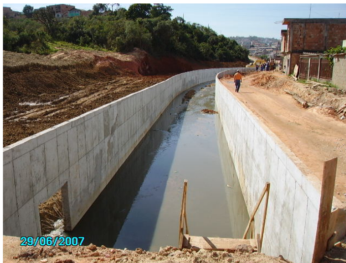
Figura 6 – Trecho de galeria concluído, com re-aterro lateral já na cota de subleito.
