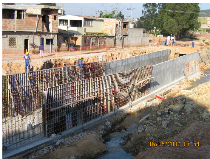
Figura 5 – Armação, forma e concretagem de paredes da galeria. Neste trecho não existe laje superior.
