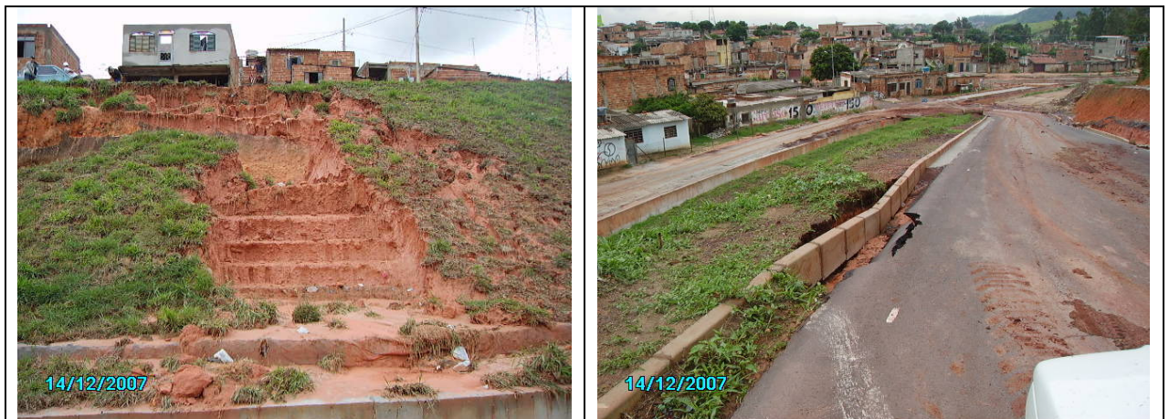
Figura 37 – Trecho de obra entre estacas E23 e E26 – Caso 02.
