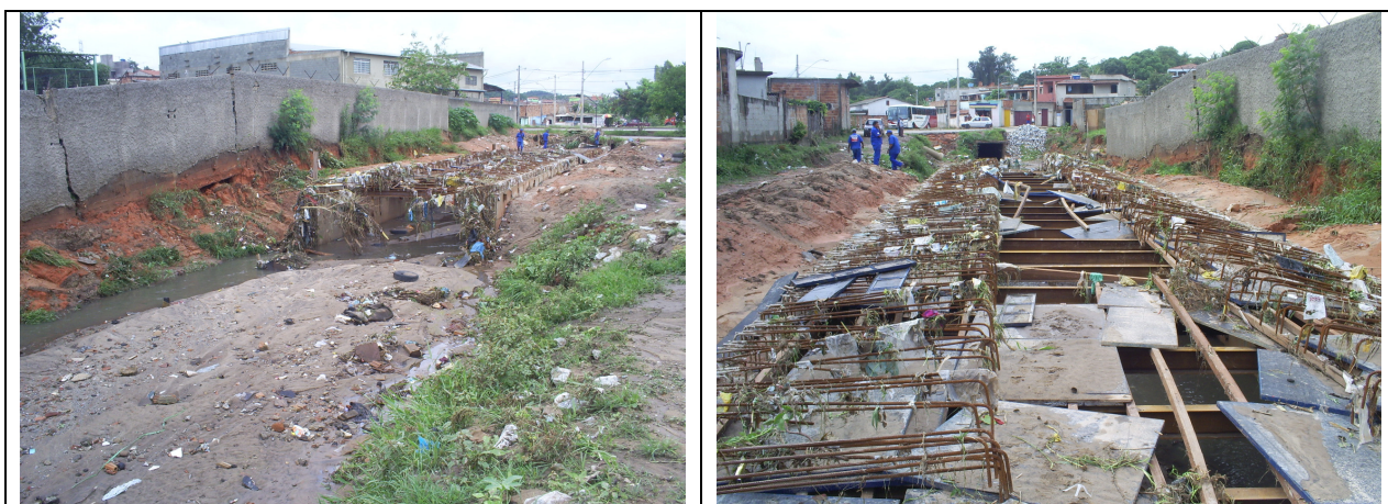
Figura 32 – Trecho de obra entre estacas E60 e E65. À esquerda, vista de montante. À direita, de jusante – Caso 01.
