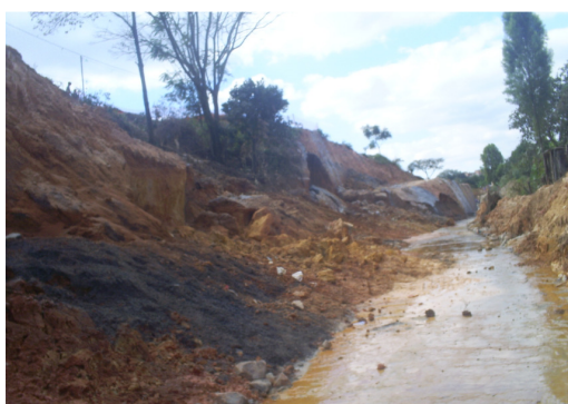
Figura 29 – Vista das bermas auxiliares executadas para possibilitar o trânsito e o trabalho dos equipamentos.
