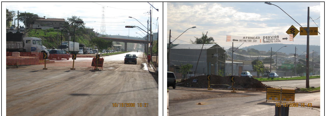
Figura 44 – Desvios de tráfego e sinalização.
