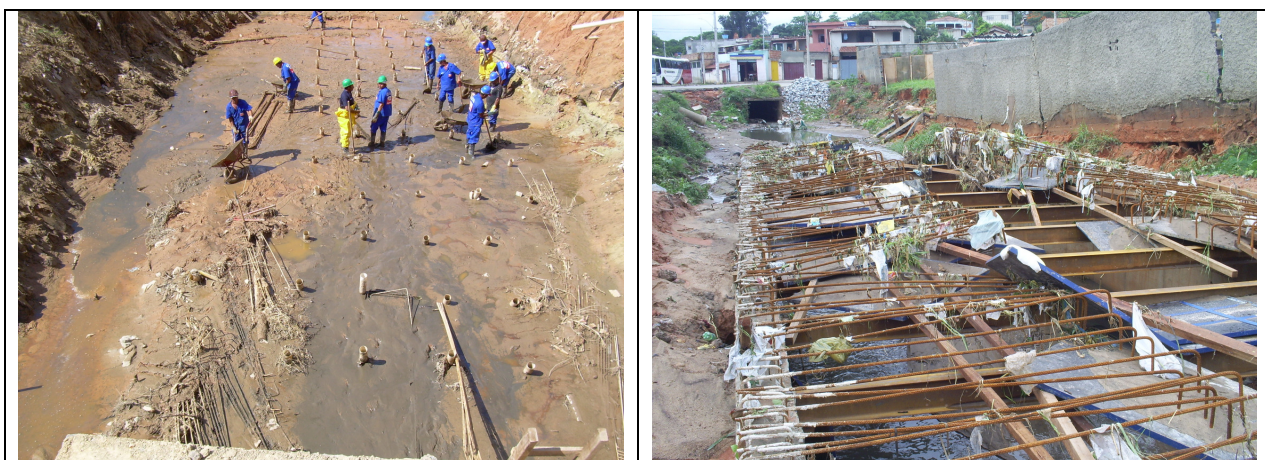
Figura 24 – Re-execução de serviços danificados pela enxurrada. À direita, estado da formas da laje superior, após a pancada d'água.
