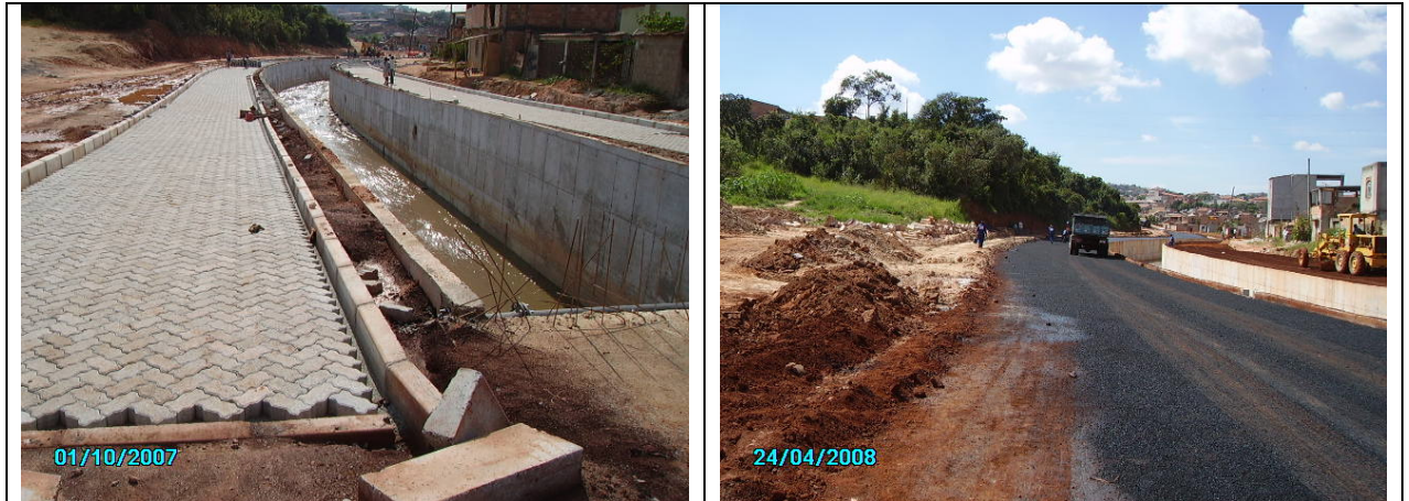
Figura 25 – Pistas, à esquerda, em PAVI-S, com 3,0 m de largura. Após alteração, à direita, sendo asfaltada, com 7,0 metros de largura
