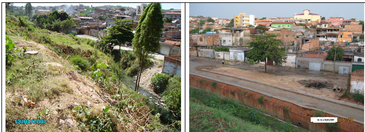
Figura 17 – Trecho entre estacas E13,0+10,0 e E20
