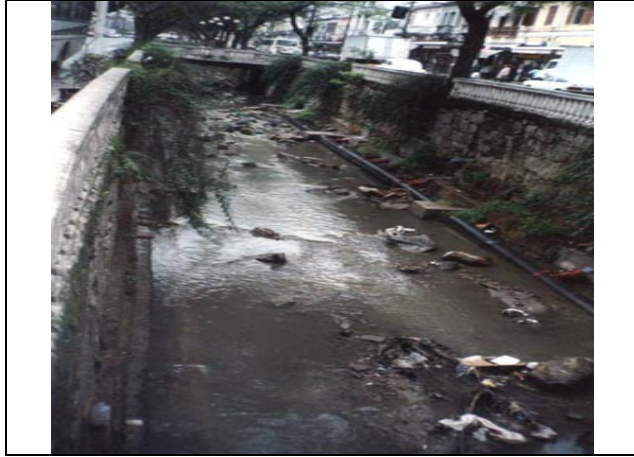
Figura 49 – Rede de esgoto, em tubos de ferro fundido, ancorada em blocos de concreto, construída dentro do canal a céu aberto que atravessa o centro da cidade.
