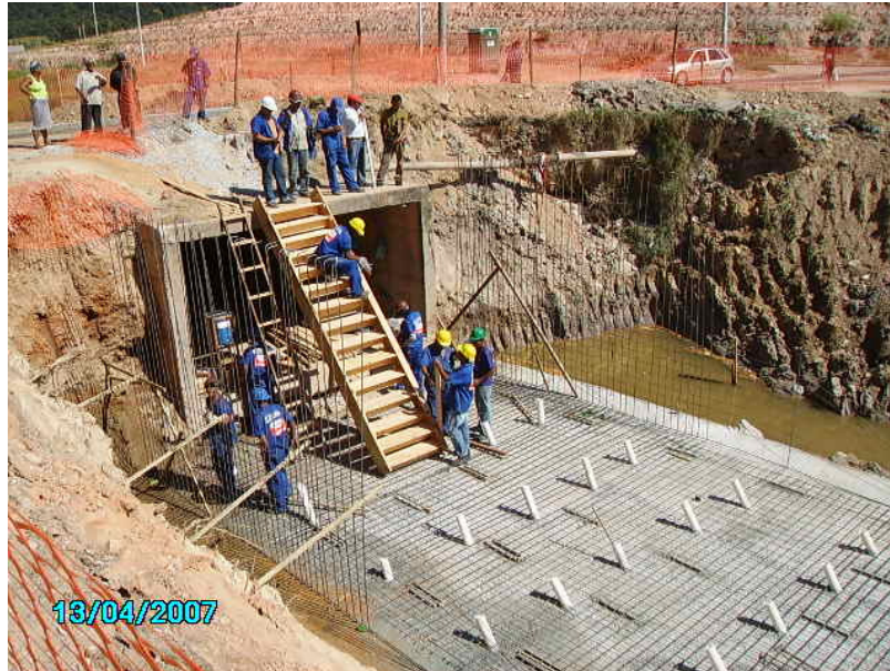
Figura 8 – Frente de serviços, pronta para concretagem, antes da pancada de chuvas.
