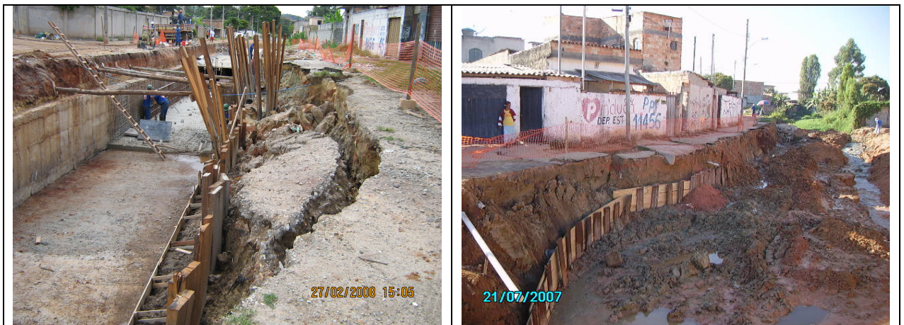
Figura 46 – Escoramentos do tipo descontínuo, com pranchões de madeira.
