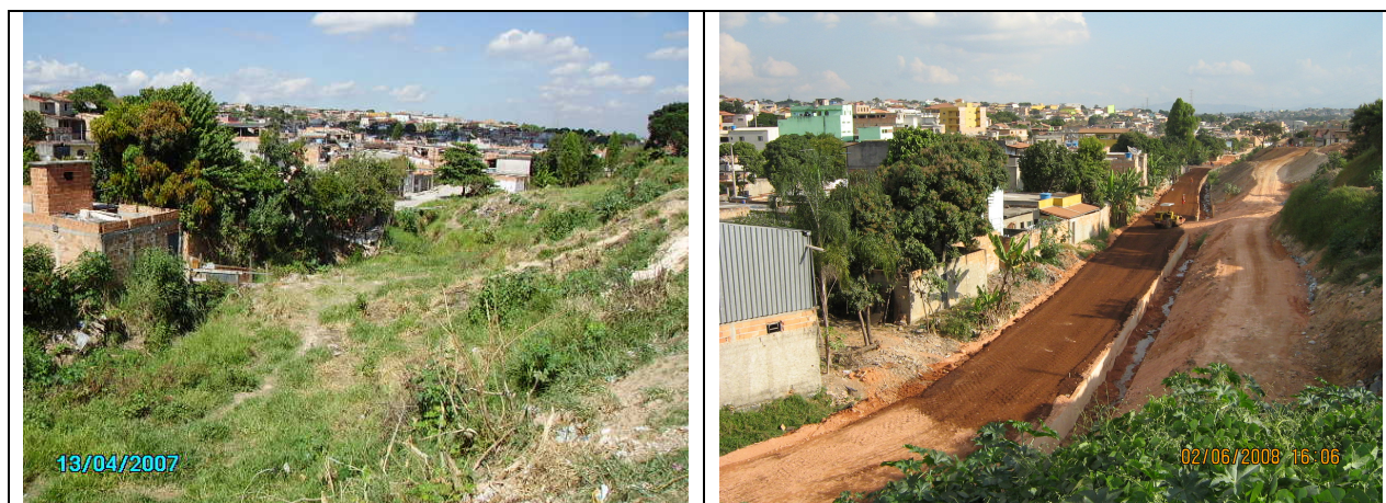
Figura 16 – Trecho entre estacas E0 e E13+10,0
