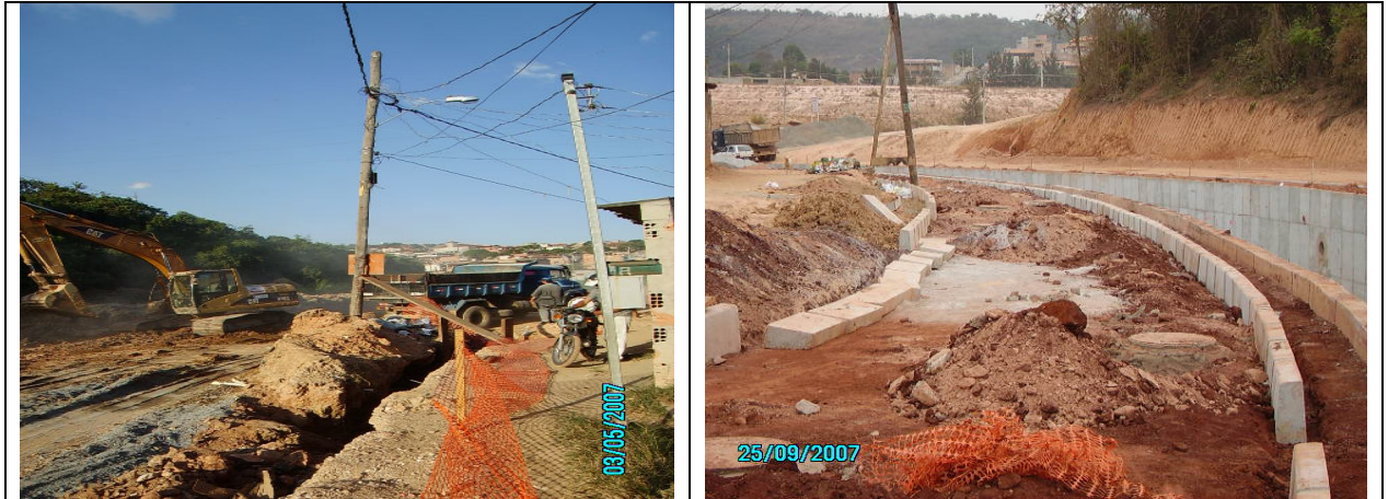
Figura 39 – Poste de energia elétrica localizado na estaca E89 – Caso 01.
