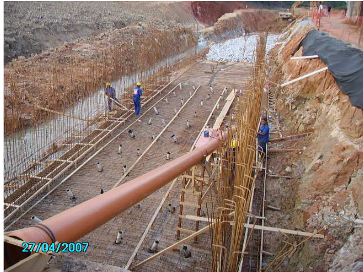
Figura 12 – Re-execução dos serviços destruídos pela enchente.
