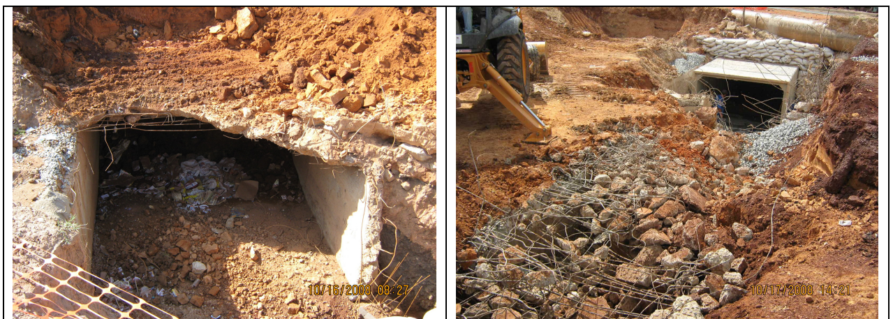
Figura 42 – Demolição de galeria não cadastrada em projeto.
