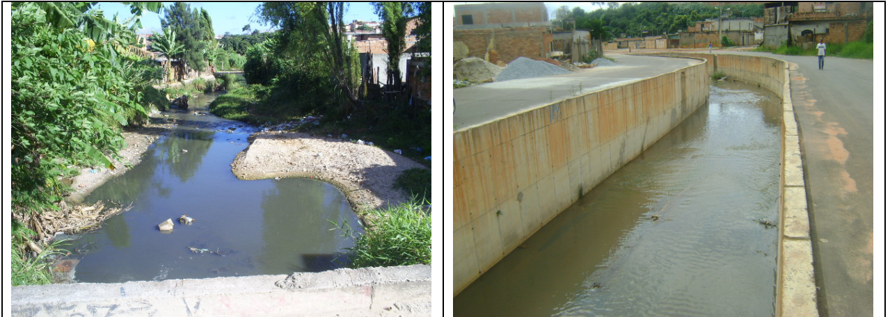
Figura 14 – Trecho entre estacas E68+10,0 e E81
