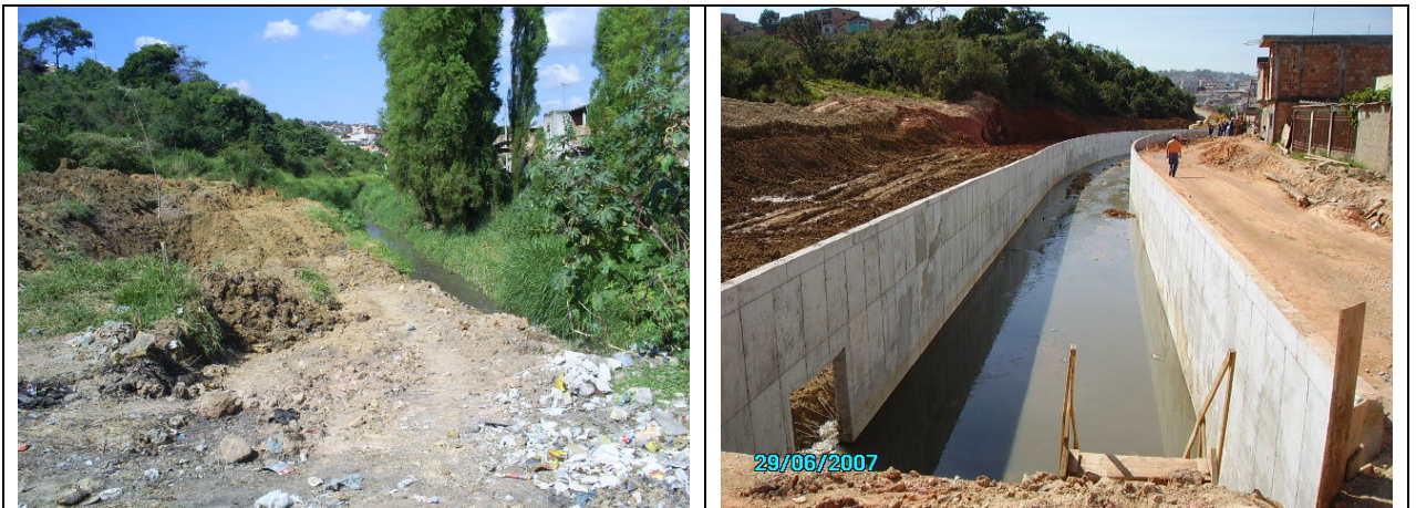
Figura 15 – Trecho entre estacas E95+7,0 e E87+10,0
