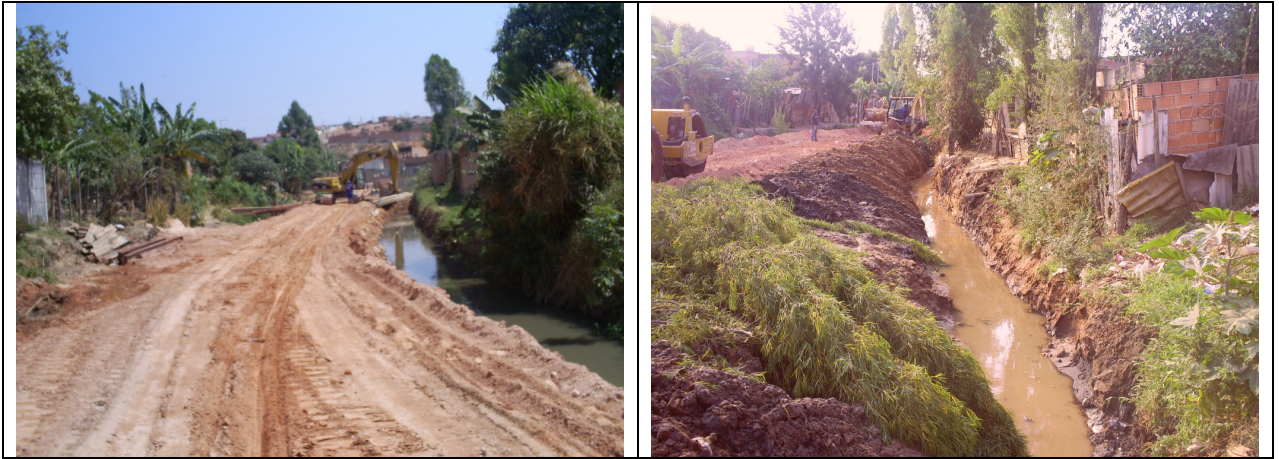
Figura 36 – Trecho de obra entre estacas E23 e E26 – Caso 02.
