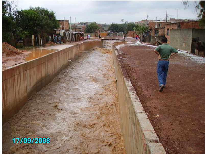
Figura 33 – Trecho de obra entre estacas E68+10,0 e E73 – Caso 01.
