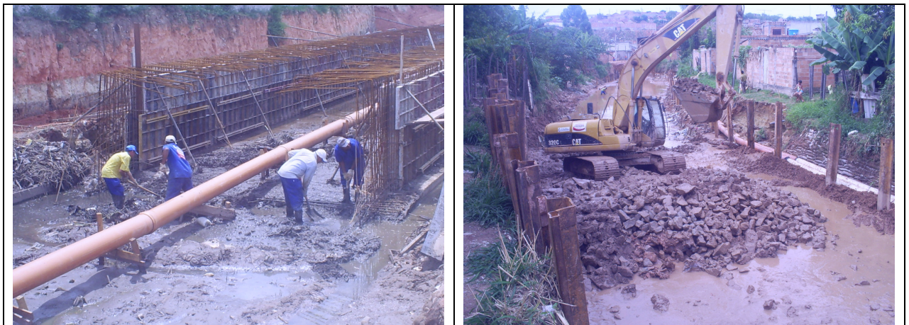
Figura 35 – Trabalho de recuperação dos trechos danificados. À esquerda, entre estacas E60 e E65. À direita, entre E73 e E80 – Caso 01.
