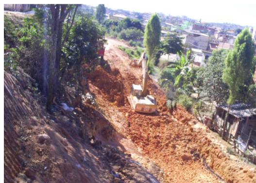
Figura 29 – Vista das bermas auxiliares executadas para possibilitar o trânsito e o trabalho dos equipamentos.
