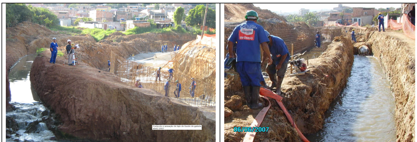
Figura 7 – “Corta-rios”: à esquerda, Caso 01. À direita, Caso 02. Detalhe para a diferença de seções.
