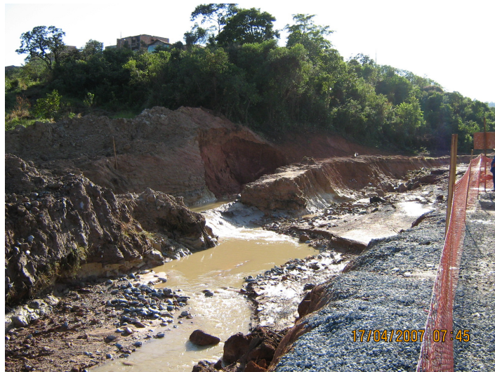
Figura 11 – “Corta-rio” e obra após a enxurrada.
