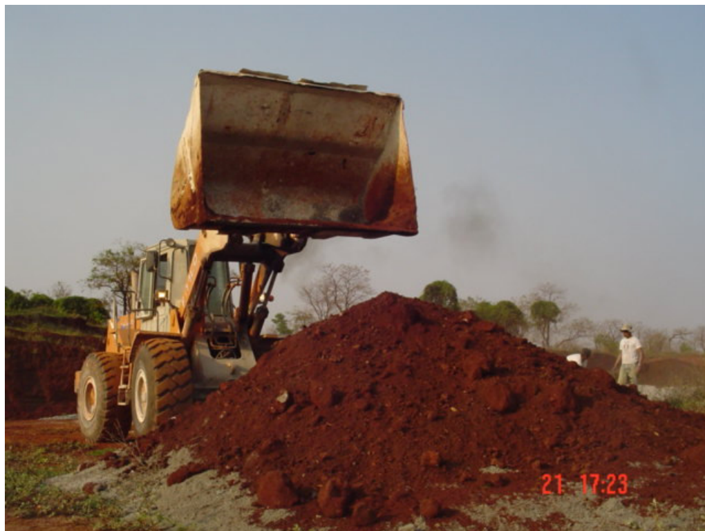
Figura 4.1 - Realização da mistura terra, calcário, RLT 1 e matéria orgânica
