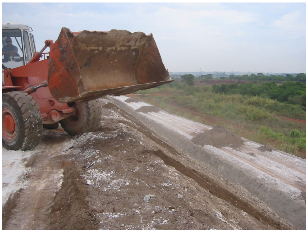
Figura 4.3 - Distribuição da mistura
