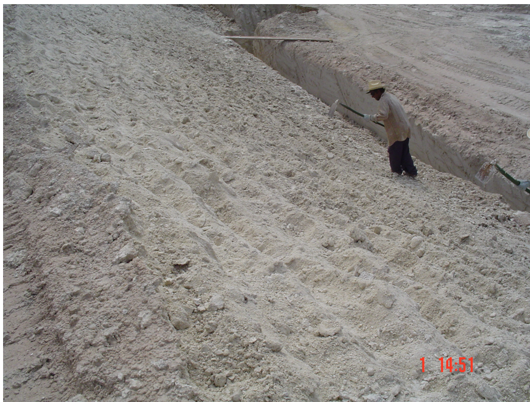
Figura 4.2 - Escarificação
