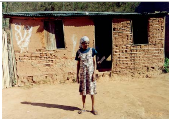
a. Edificações em pau a pique (moradias)
