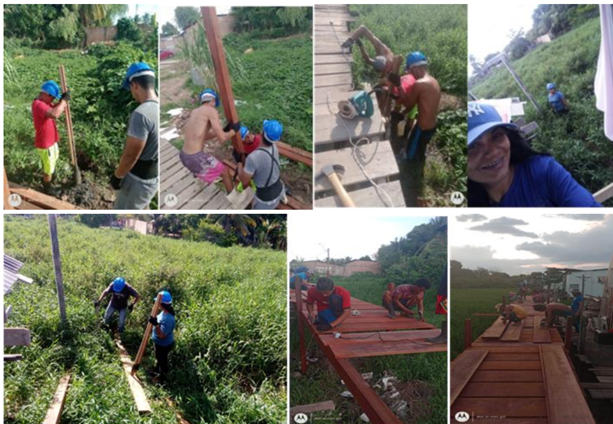
Figura 75 – Reforma das pontes.
