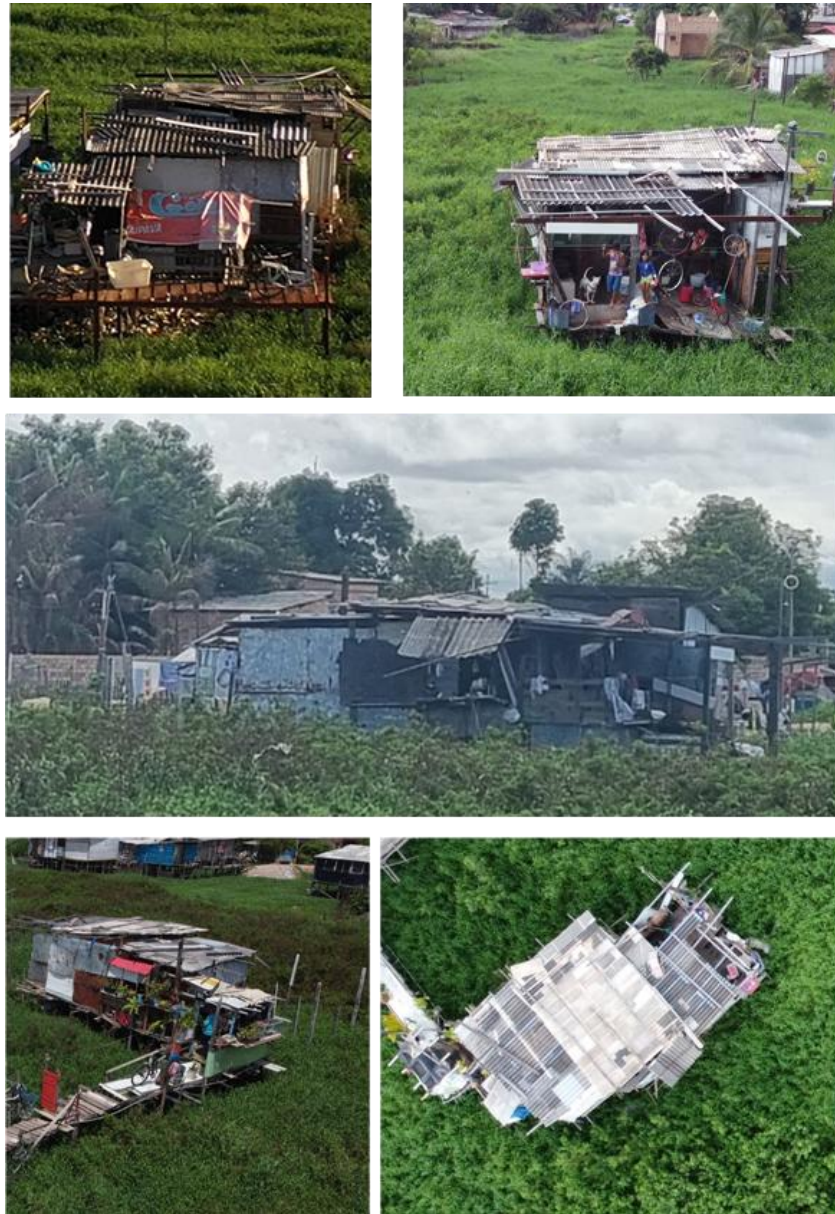
Figura 19 – Vistas da casa de Keyla e Alberto. Na sequência: fachada frontal, fachada posterior, fachada lateral direita, fachada lateral esquerda e cobertura.
