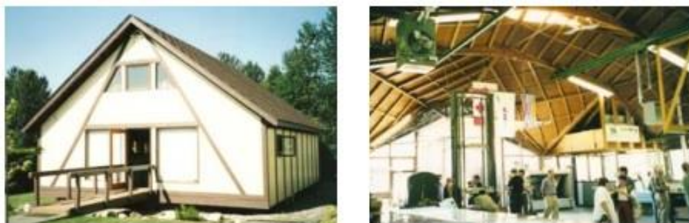
Figura 17: Habitação padronizada de condomínio nos EUA, com aplicação de chapas OSB nas vedações e coberturas.
