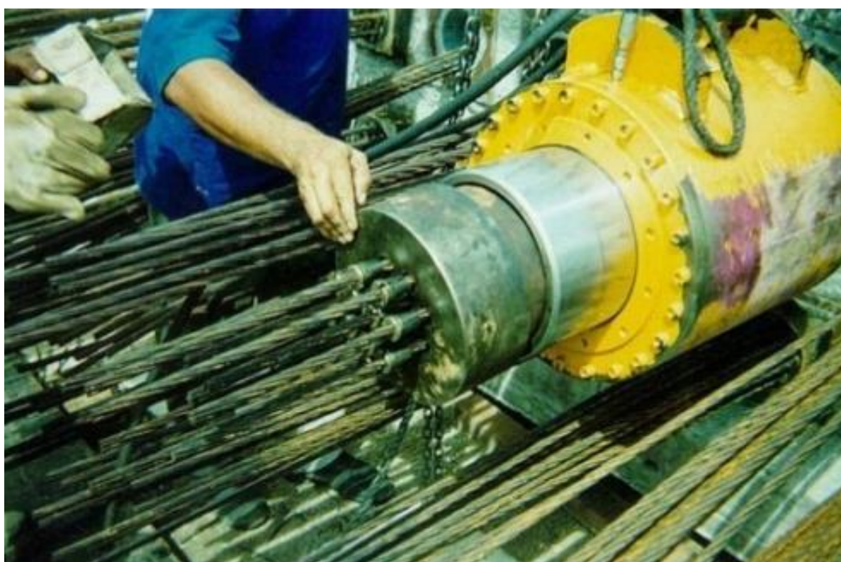
Figura 20: Macaco hidráulico para protensão (Pfeil, 1984)
