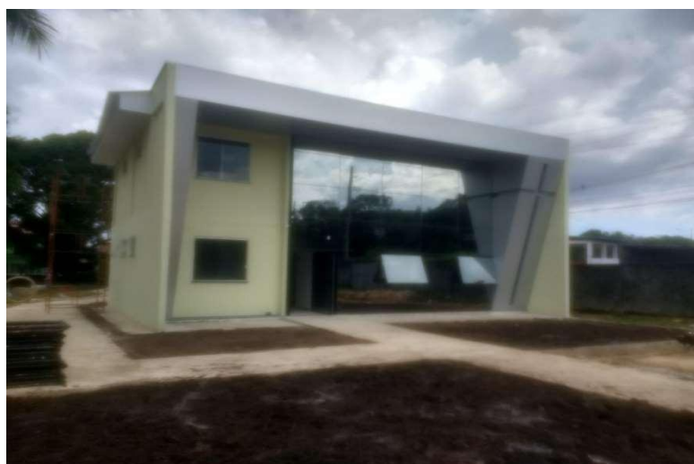
Figura 3: Vista da fachada frontal
