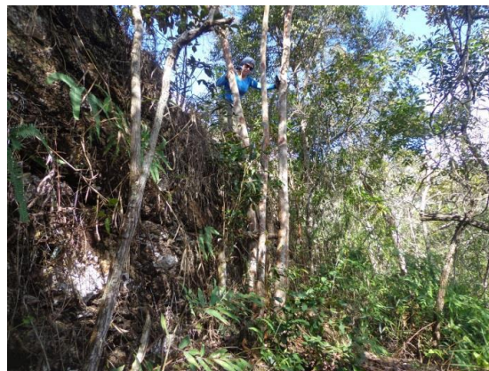
FIGURA 24 - Vista geral de um muro de uma das estruturas, coberto por vegetação. Local identificado no plano de manejo Fonte: MINAS GERAIS, 2017, p. 84.
