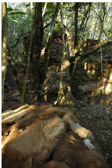
FIGURA 126 - Vista frontal do Muro (centro da foto). À esquerda a área do Arrimo 2 e à direita Plataforma do Rejeito 4.
