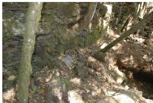
FIGURA 124 - Vista parcial do Arrimo 2 – 2
