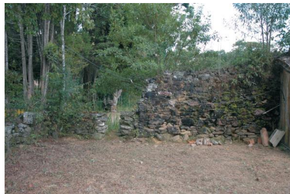
FIGURA 32 - Tripuí: vestígio de edificação – parede Fonte: GUIMARÃES, 2007, p. 176, 48
