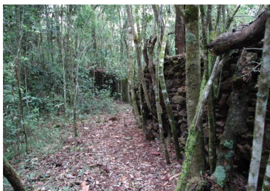
FIGURA 78 - Muro de cercamento da área dos currais
