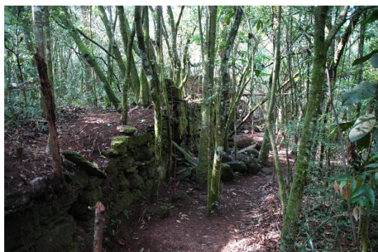
FIGURA 125 - Vista geral do Arrimo 2
