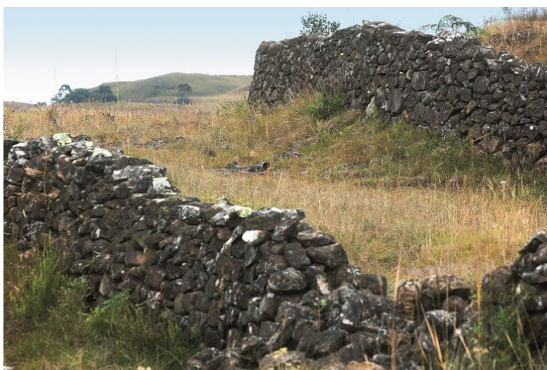
FIGURA 2 - Detalhe do corredor com os muros de “taipa” Autoria: Ricardo Almeida Sem identificação de data e local. Fonte: Acervo do Iphan/SC. Cedida por Edenir Perin.
