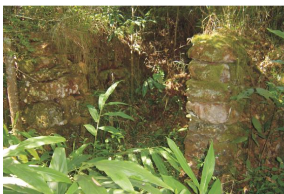
FIGURA 33 - Tripuí: vestígios de edificação Fonte: GUIMARÃES, 2007, p. 176, 48.
