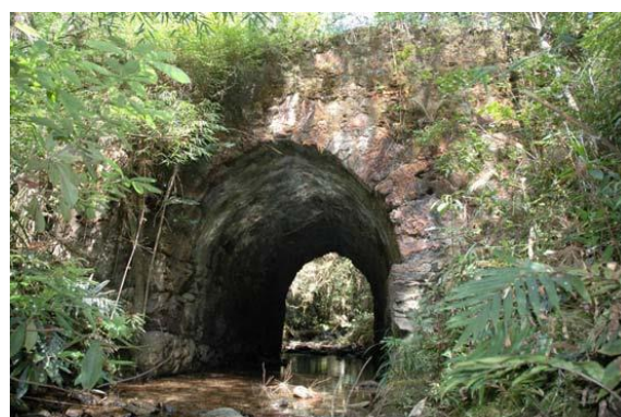
FIGURA 34 - Ponte do Tripuí Fonte: GUIMARÃES, 2007, p. 176, 48
