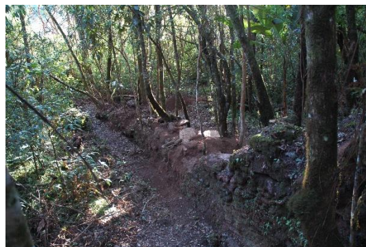
FIGURA 127 - Vista do Muro a partir da Plataforma do Rejeito 4
