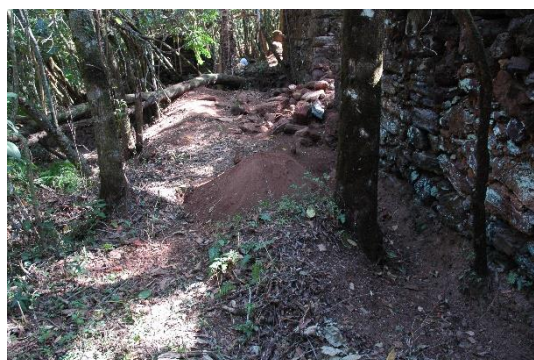
FIGURA 129 - Vista geral da Plataforma do Rejeito 4, com Muro ao fundo
