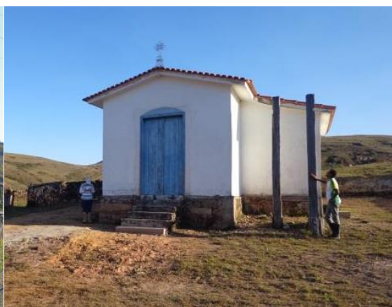
FIGURA 20 - Capela Nossa Senhora das Dolores de Bela Vista. Provável Chiqueiro Fonte: MINAS GERAIS, 2017, p. 74.
