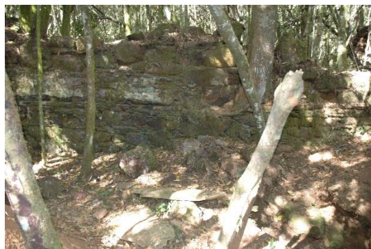
FIGURA 123 - Vista parcial do Arrimo 2
