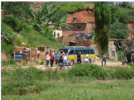
Figura 36: Ocupação irregular em área de preservação permanente. Casas em cima de nascentes. Drenagem das nascentes ocorre em meio a rua em direção ao córrego da Av. Dois. Visita técnica NJGC e Manuelzão Comunidade. Acervo Núcleo João Gomes Cardoso, novembro de 2009.
