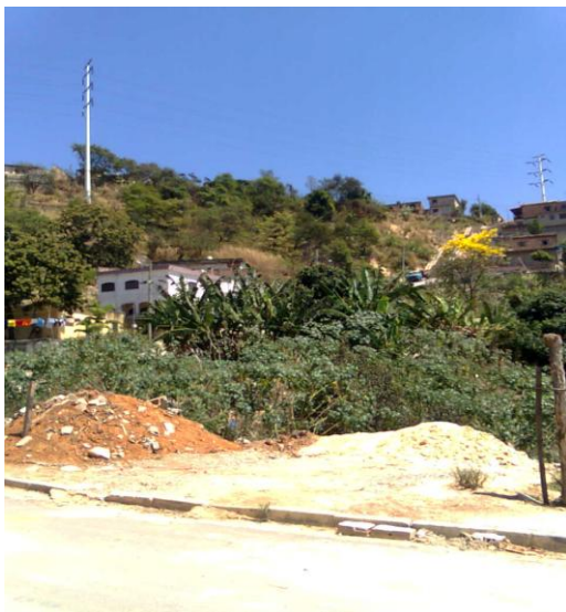
Figura 26: Visita dos integrantes e parceiros do NJGC as nascentes, área verde e córrego da Av. Dois. Ocupação irregular em área de APP. Acervo Núcleo João Gomes Cardoso, setembro de 2009.
