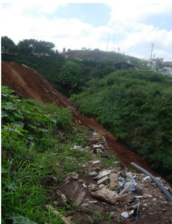
Figura 38: Área com aterro realizado por empresa sem cobertura de vegetação nas regiões íngremes acarretando em erosão e assoreamento de corpos d'água. Visita técnica NJGC e Manuelzão Comunidade. Acervo Núcleo João Gomes Cardoso, novembro de 2009.
