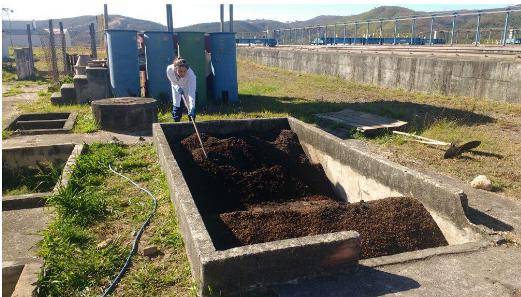
Figura 4.11 – Detalhe do reviramento do material constituinte das pilhas
