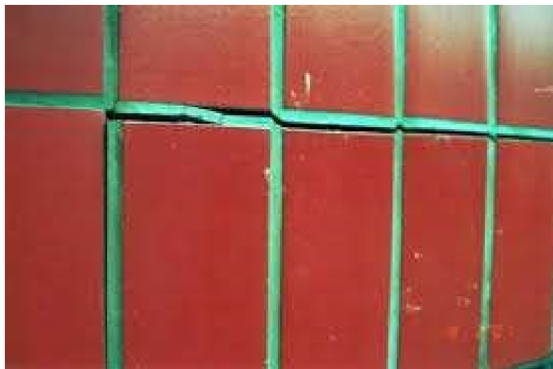
Figura 08: Gretamento em fachada cerâmica
