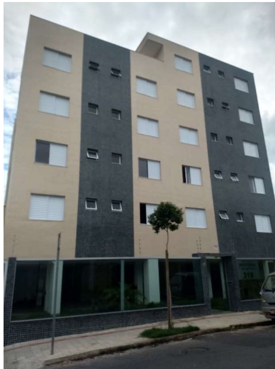
Figura 19: Fachada em cerâmica, edifício 02
