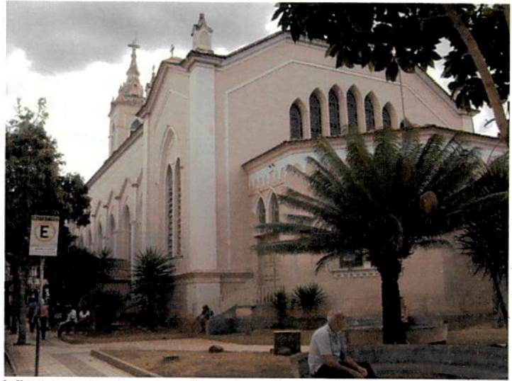
Visão exterior dos fundos da Igreja Nossa Senhora da Conceição
