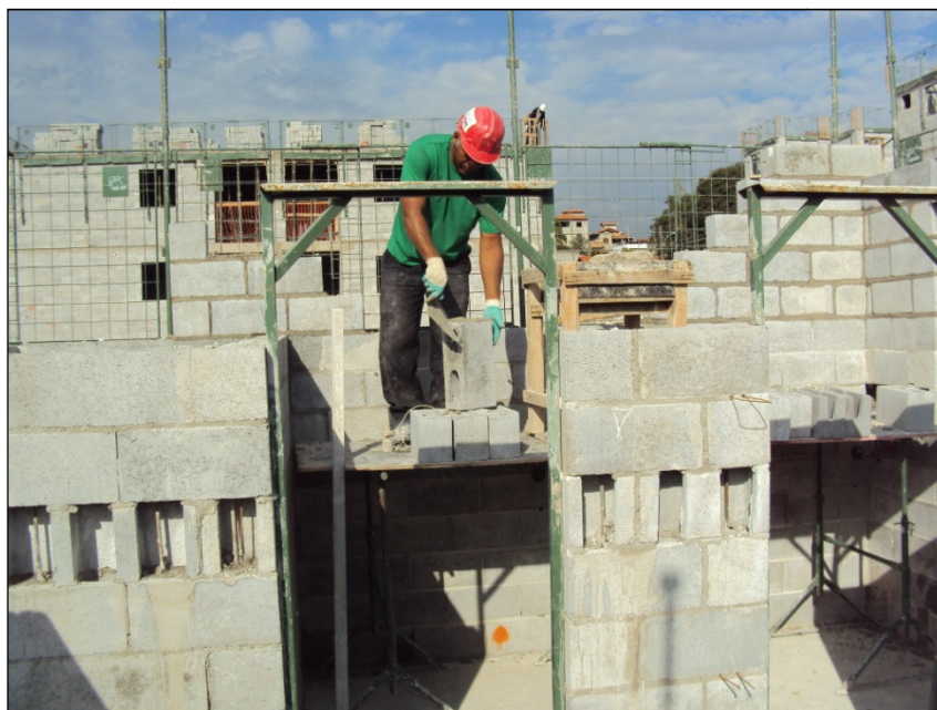
Figura 3.31: Utilização de gabaritos para vãos de portas Fonte: Acervo do Autor
