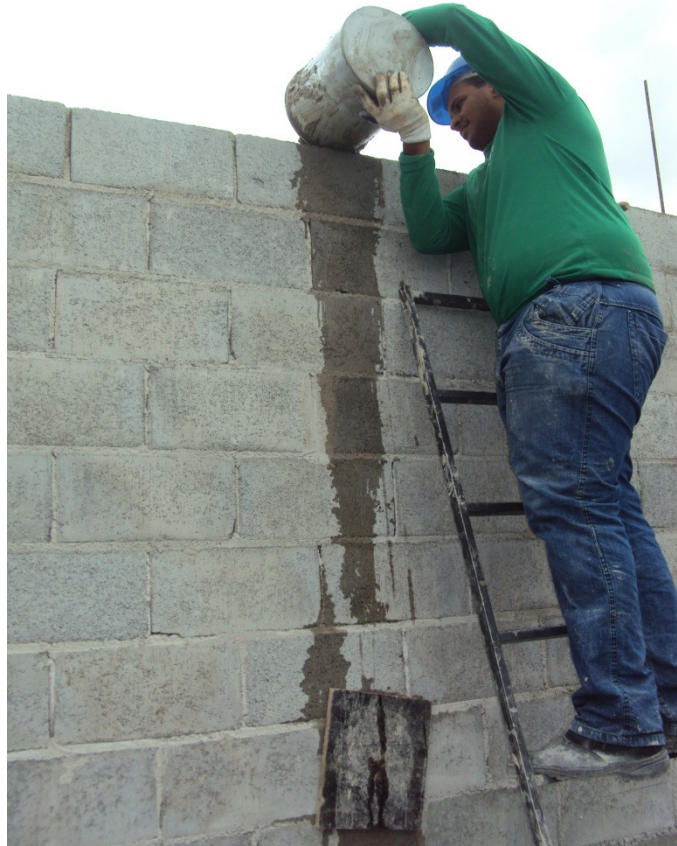
Figura 4.2: Molhação antes do grauteamento Fonte: Acervo do Autor
