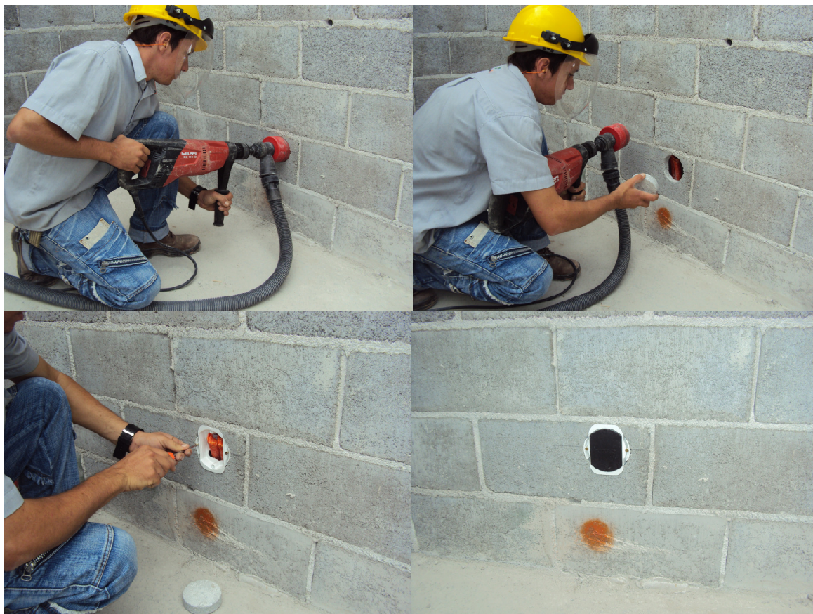
Figura 4.1: Instalação de Caixas Elétricas Fonte: Acervo do Autor
