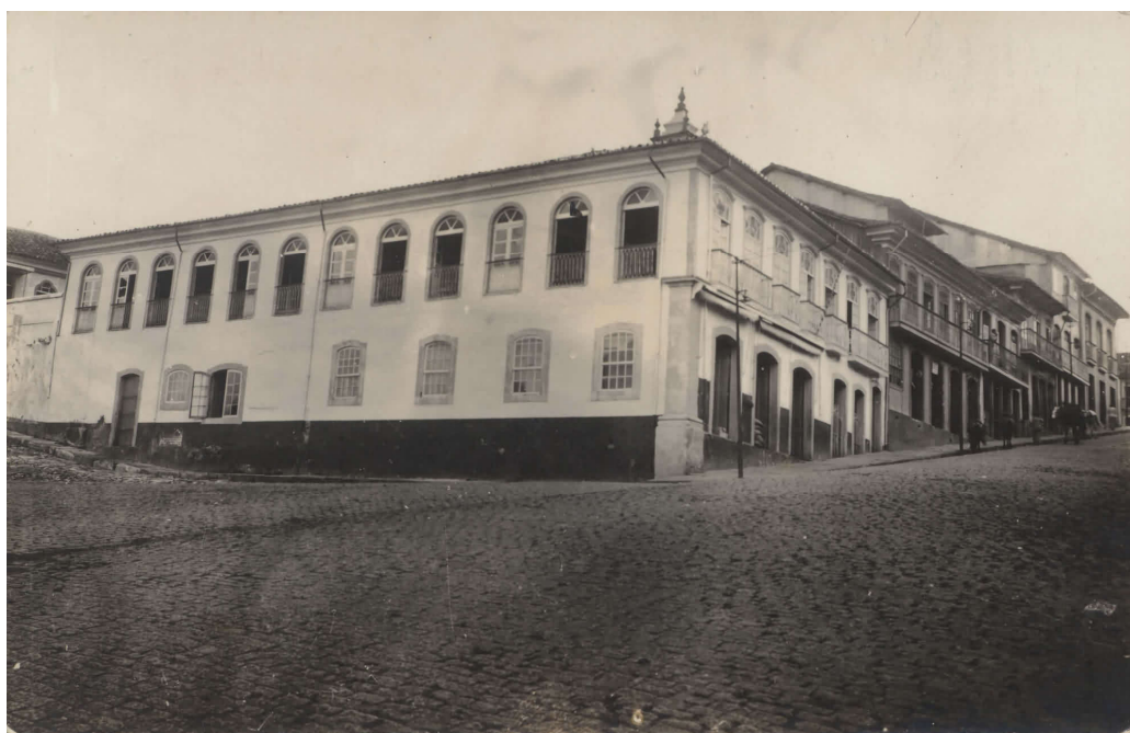
Fotografia 4 – Edificação que abrigou a Escola Normal de Ouro Preto, 1910. A escola ficou instalada neste prédio até 1925, acervo particular.
