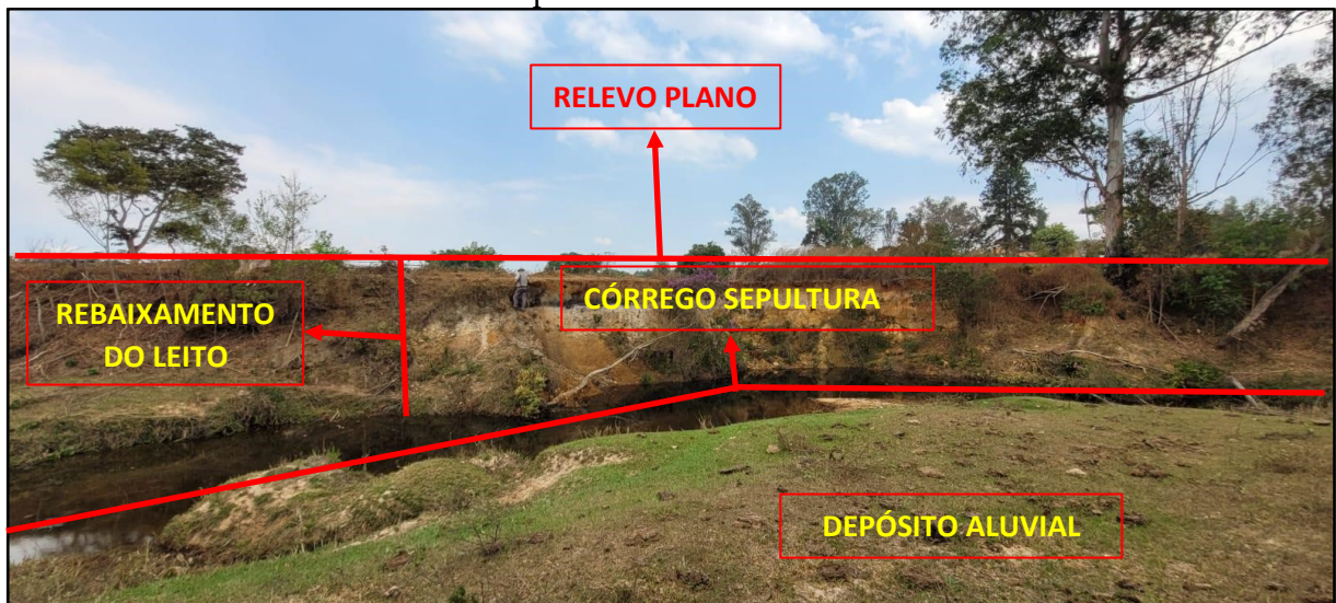
Figura 18 - Visão de parte do córrego Sepultura destacando o rebaixamento do seu leito devido ao processo erosivo do seu canal
