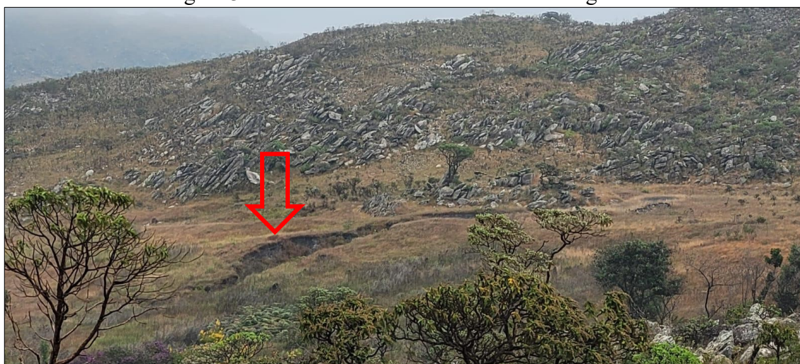
Figura 32 – Corte com acúmulo de material orgânico
