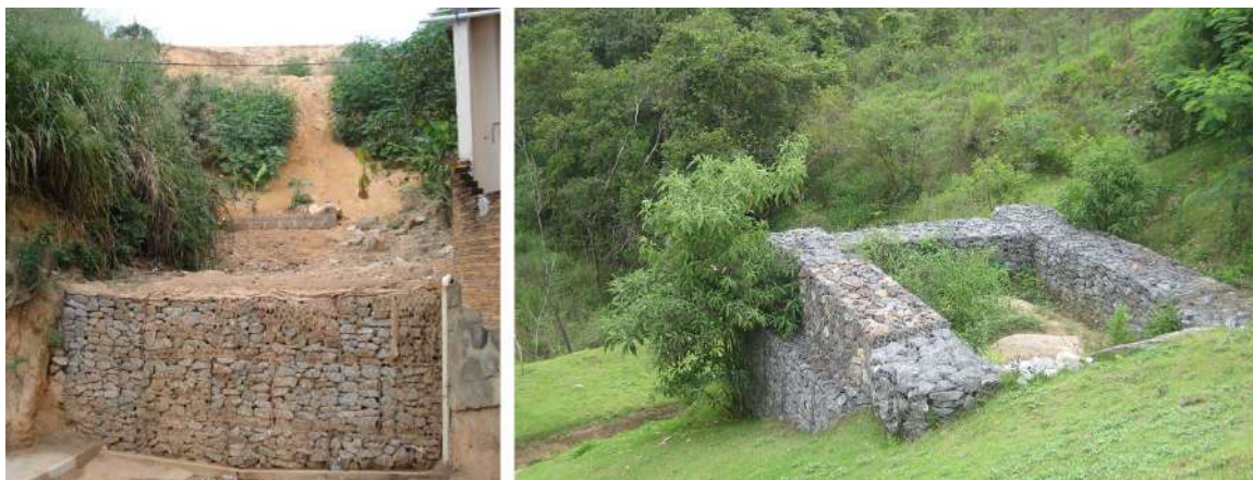
Figura 19: Aterro de resíduos (Belo Horizonte) e caixa drenante de gabião (condomínio em Nova Lima)
