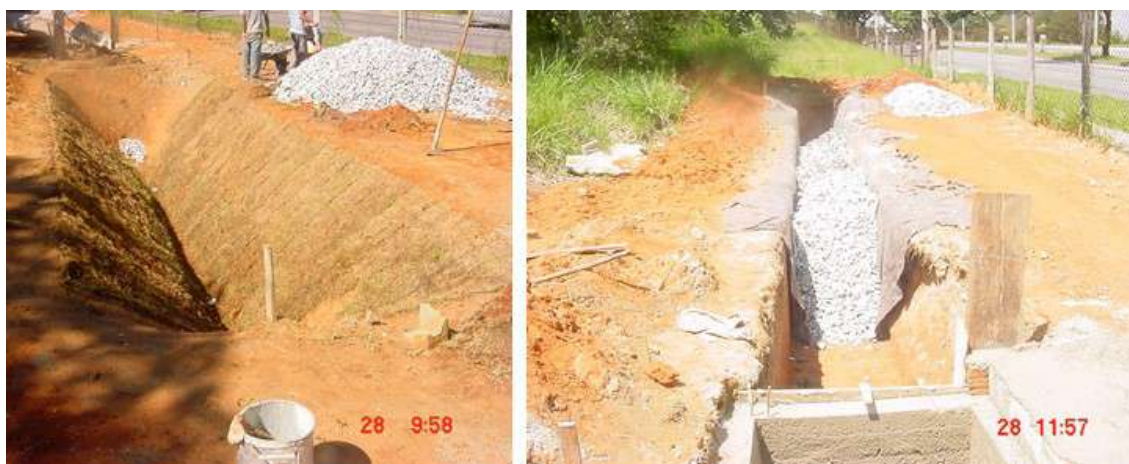
Figura 15: execução de trincheira e vala de retenção no Campus da UFMG
