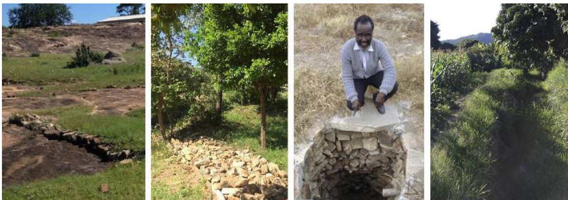
Figura 5: Intervenções para captação, armazenamento e infiltração da água
