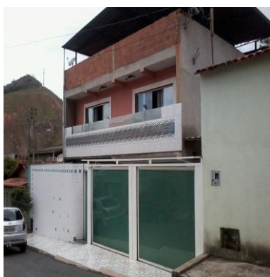
Vista frontal da edificação
