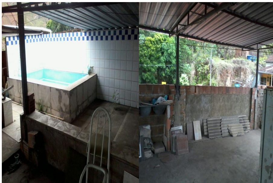
Área do terraço, construção incompleta
