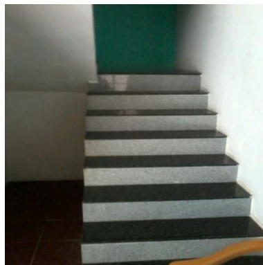
Escada de acesso ao 2º Pavimento
