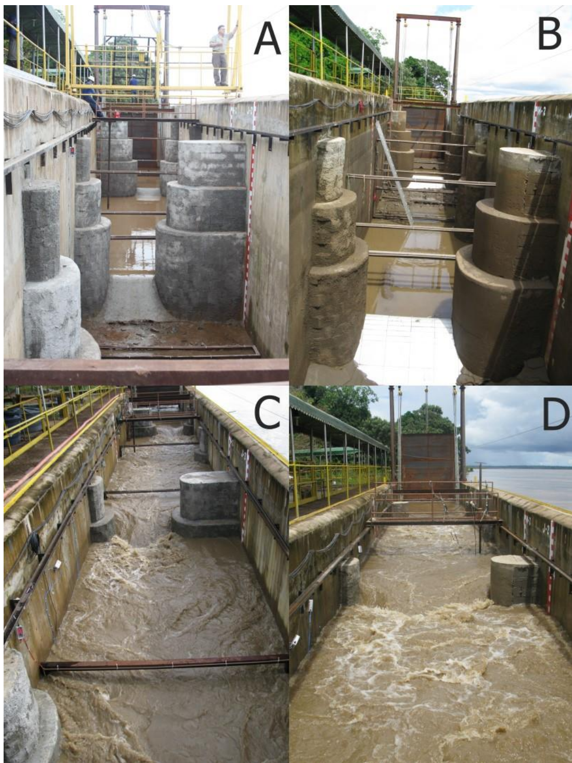
Figura 1.3: Dissipadores construídos no CET. As molduras de madeiras dão suporte às antenas do sistema de identificação por radiofrequência (SIRF). A: largura da ranhura de 1,1 m (Configuração 1); B: largura da ranhura de 1,6 m (Configuração 2). Soleira na base da ranhura coberta com azulejos brancos. C: Fluxo no Tanque 2 no Configuração 1; (foto: Alexandre Godinho) D: Fluxo no Tanque 2 no Configuração 2.
