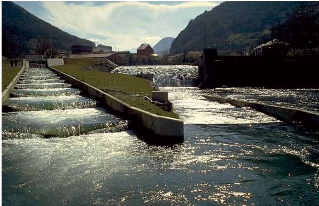
Figura 4 – Mecanismo de Transposição do Tipo Tanque com Vertedor do rio Nester na França. Fonte: Larinier, 2001
