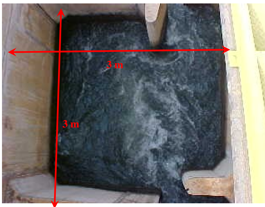
Figura 13 – Tanques do MTP da UHE de Igarapava Fonte: Viana 2005.
