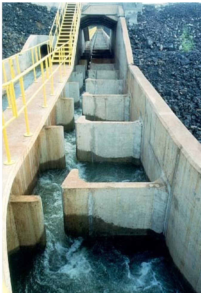
Figura 7 – Mecanismo de Transposição de Peixes do Tipo Ranhura Vertical Simples localizada no Rio Grande na UHE de Igarapava Fonte: CEMIG, 2002
