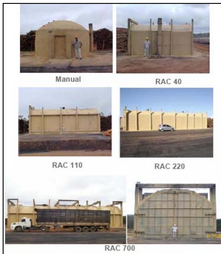
Figura 24 – Evolução dos fornos de carbonização. Fonte: ArcelorMittal Timóteo /Jequitinhonha, 2007
