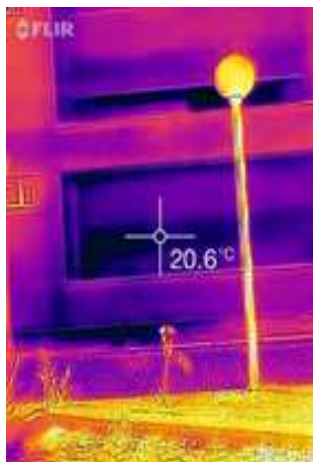
a) Imagem termográfica – posição câmera 00
