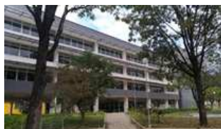
Figura 10: Edifício CAD 3 - UFMG
