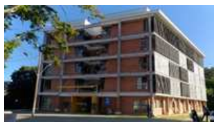
Figura 1: Edifício das Licenciaturas UFV Fonte: Mariane Cal, 2018
