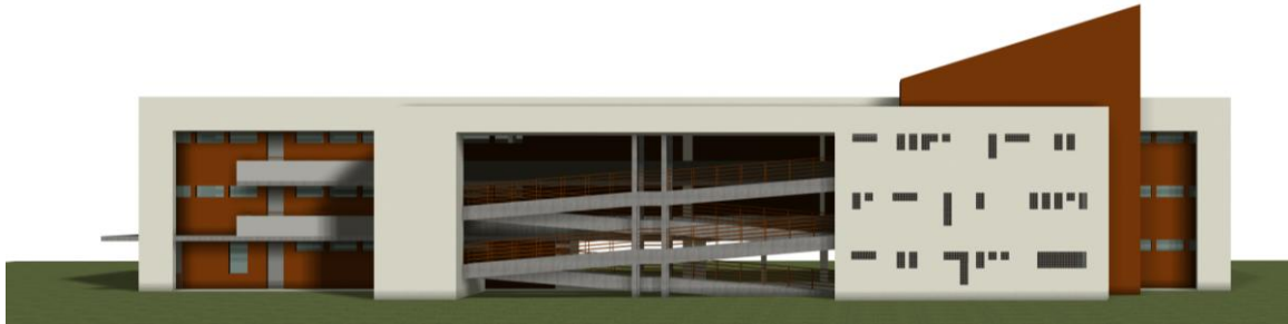
Figura 6 – Fachada posterior do PE-3PAV.
