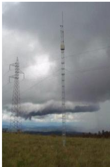
Figura 2.21 Visualização da torre de medição do vento que está próxima a uma Linha Aérea na região de Acuruí-MG.
