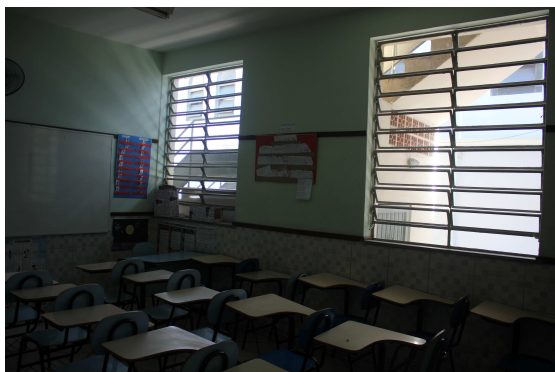
FIGURA 64 – [SALA DE AULA IMÓVEL 2]
