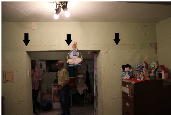
FIGURA 49 – [VÃO SEM VERGA]
