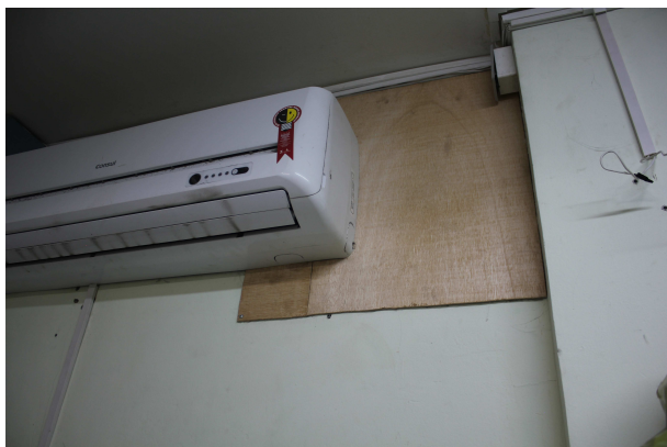
FIGURA 63 – [INSTALAÇÃO DE SPLIT NO IMÓVEL 2]
