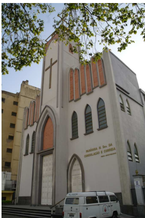
FIGURA 8 – [IMÓVEL 1: IGREJA NOSSA SENHORA DA CONSOLAÇÃO E CORRÊA]
