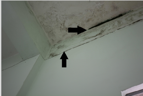
FIGURA 38 – [DETALHE INFILTRAÇÃO]
