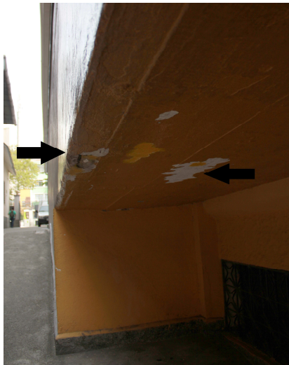
FIGURA 33 – [VIGA COM BAIXO RECOBRIMENTO]
