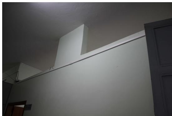
FIGURA 67 – [SALA DE AULA IMÓVEL 2]
