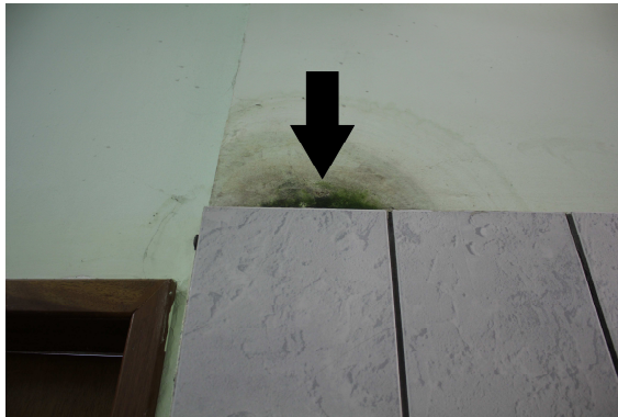
FIGURA 55 – [INFILTRAÇÃO]
