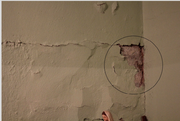
FIGURA 50 – [ARGAMASSA INADEQUADA]
