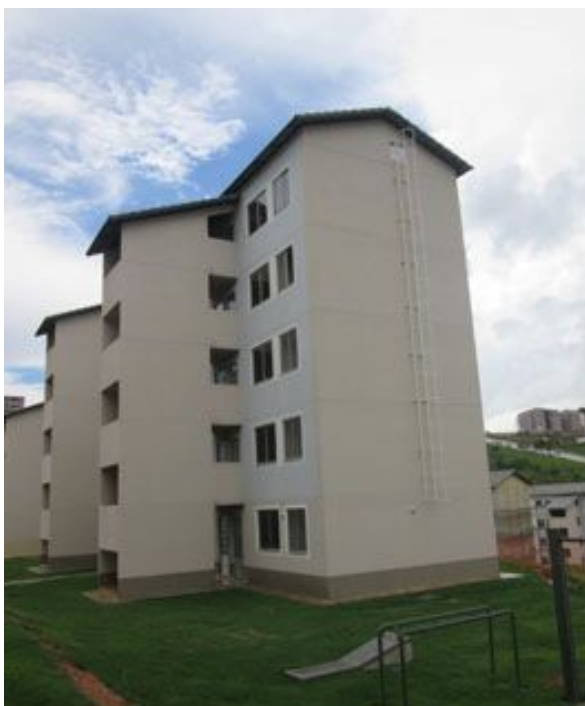
FIGURA 7 - Conjunto Habitacional Parque Real – 880 apartamentos para a Faixa 1 e 660 para a Faixa 2 – EMCCAMP Residencial – EM EXECUÇÃO
