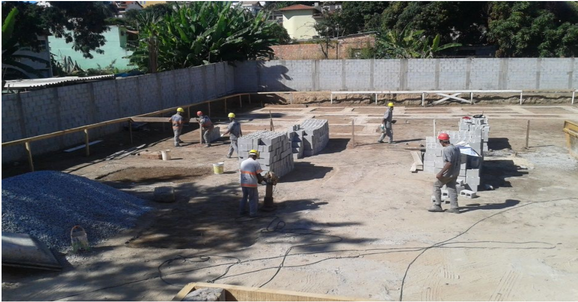
FIGURA 10 - Obra em andamento do Residencial do Córrego do Ferrugem
