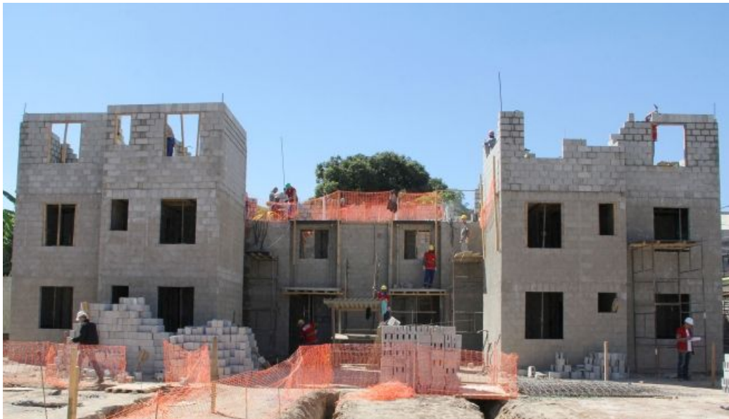
FIGURA 9 - Obra em andamento do Residencial do Córrego do Ferrugem
