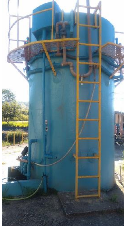
Figura 17 - Imagem do reator UASB em escala de demonstração.
