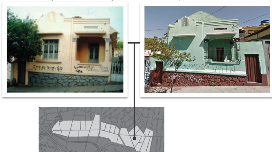
Figura 39: Rua Pouso Alegre, 1.222 – descaracterização do bem tombado
