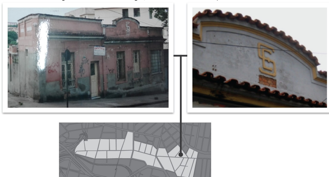
Figura 40: Rua Pouso Alegre, 1.273 – descaracterização do bem tombado
