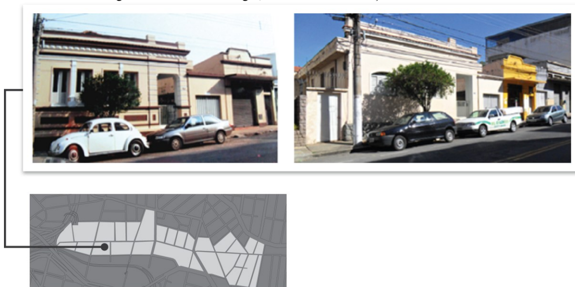
Figura 41: Rua Pouso Alegre, 396 – descaracterização do bem tombado
