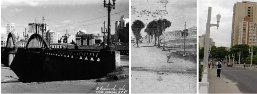
Figura 11: Vistas dos viadutos de Santa Tereza e Floresta
