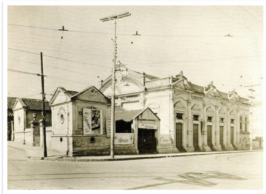
Figura 14: Fachada principal do Cine Floresta
