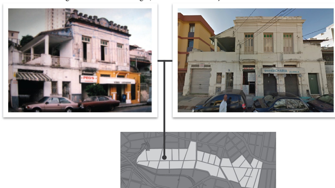
Figura 42: Rua Pouso Alegre, 357 – descaracterização do bem tombado
