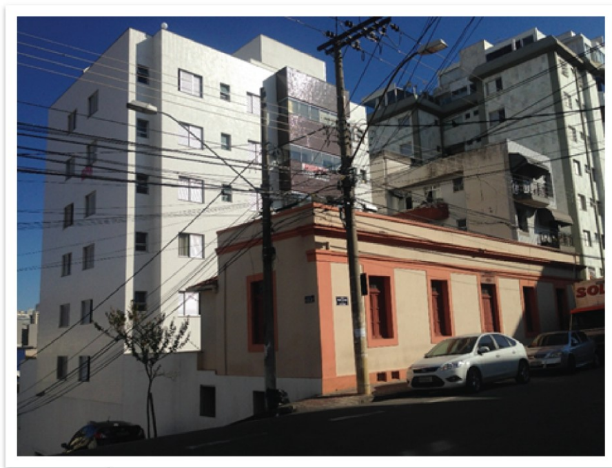
Figura 36: Rua Pouso Alegre, 404 – restauração do bem tombado
