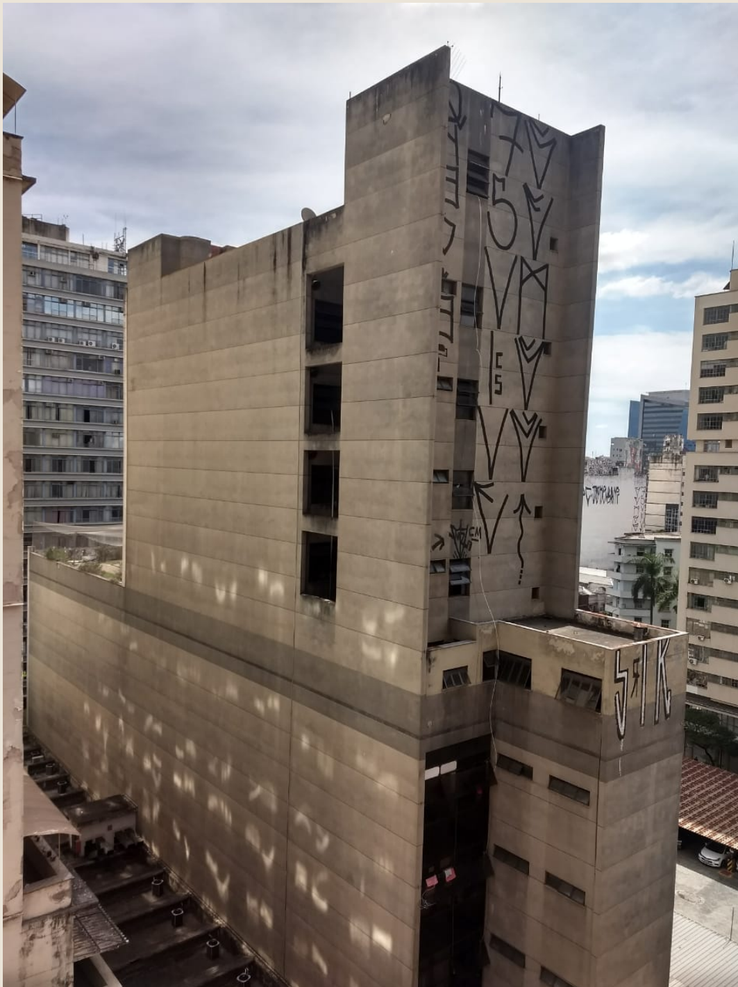
Figura 12: Vista dos fundos do edifício da Vicentão. Detalhe da fachada lateral sem aberturas para ventilação e iluminação. Fonte: Acervo da disciplina ARQ013, 2018.
