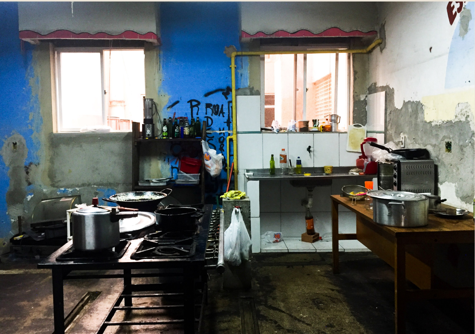
Figura 21: Cozinha compartilhada no térreo do edifício da Manoel Congo, onde antigamente era o lugar da creche. Fonte: Acervo próprio, 2019.
