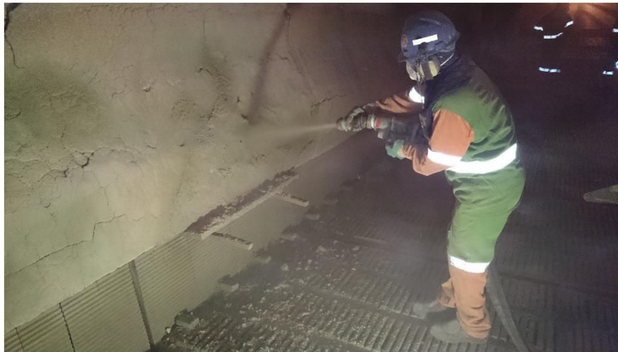
Figura 2.25 – Foto ilustrativa - aplicação de concreto refratário por projeção a seco ( gunning ) Fonte: MAGNESITA REFRATÁRIOS S.A..
