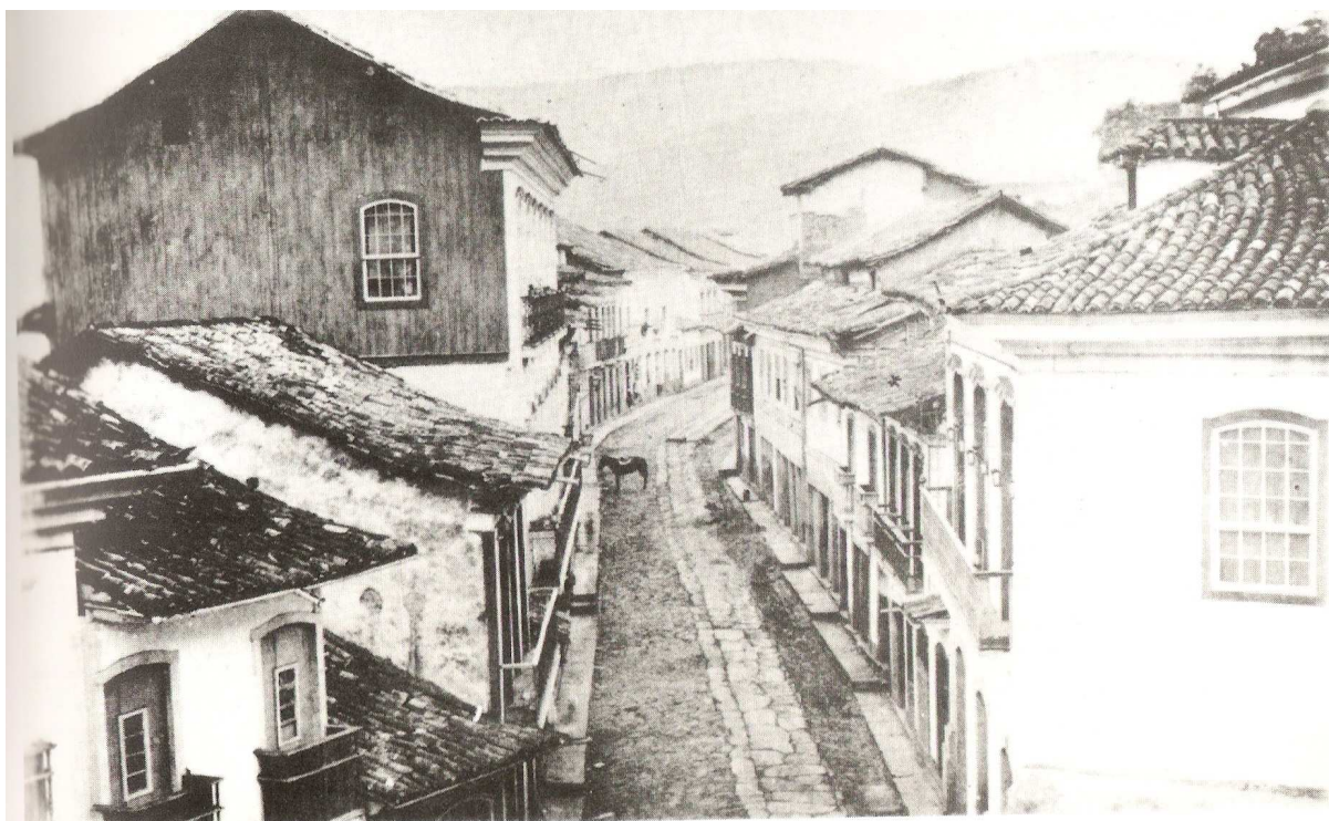
FIGURA 47 - Rua Tiradentes em 1875-80, com a utilização de capistrana nas vias. Fonte: FERREZ, 1946, p. 231.
