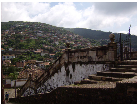
FIGURA 73 - Vista da Igreja de Santa Efigênia Fonte: Acervo da autora, 2009.
