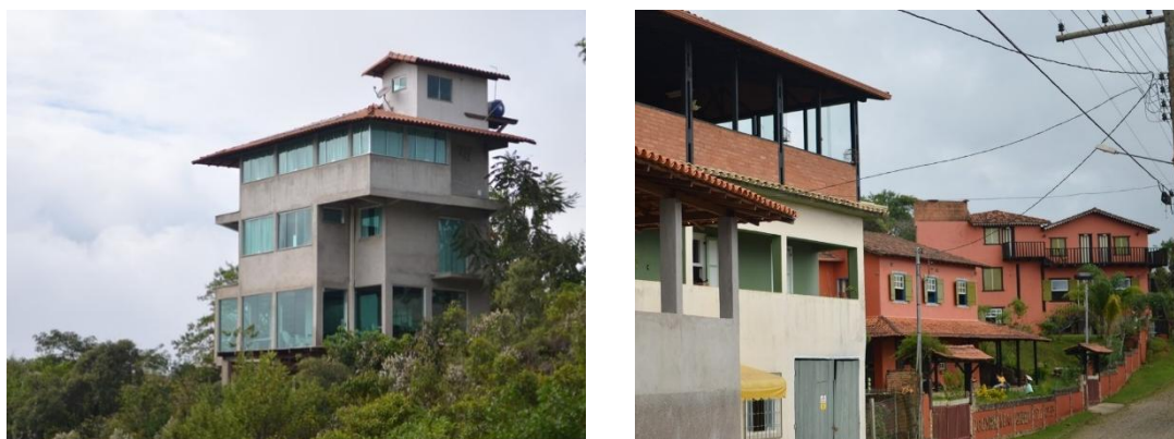
FOTO 4: Construções de três andares, na rua lateral ao centro histórico de Lavras Novas. A foto à esquerda é uma casa no Alto do Campo, localizada em áreas de nascentes. Fotografia Thiago Almeida, 2014.
