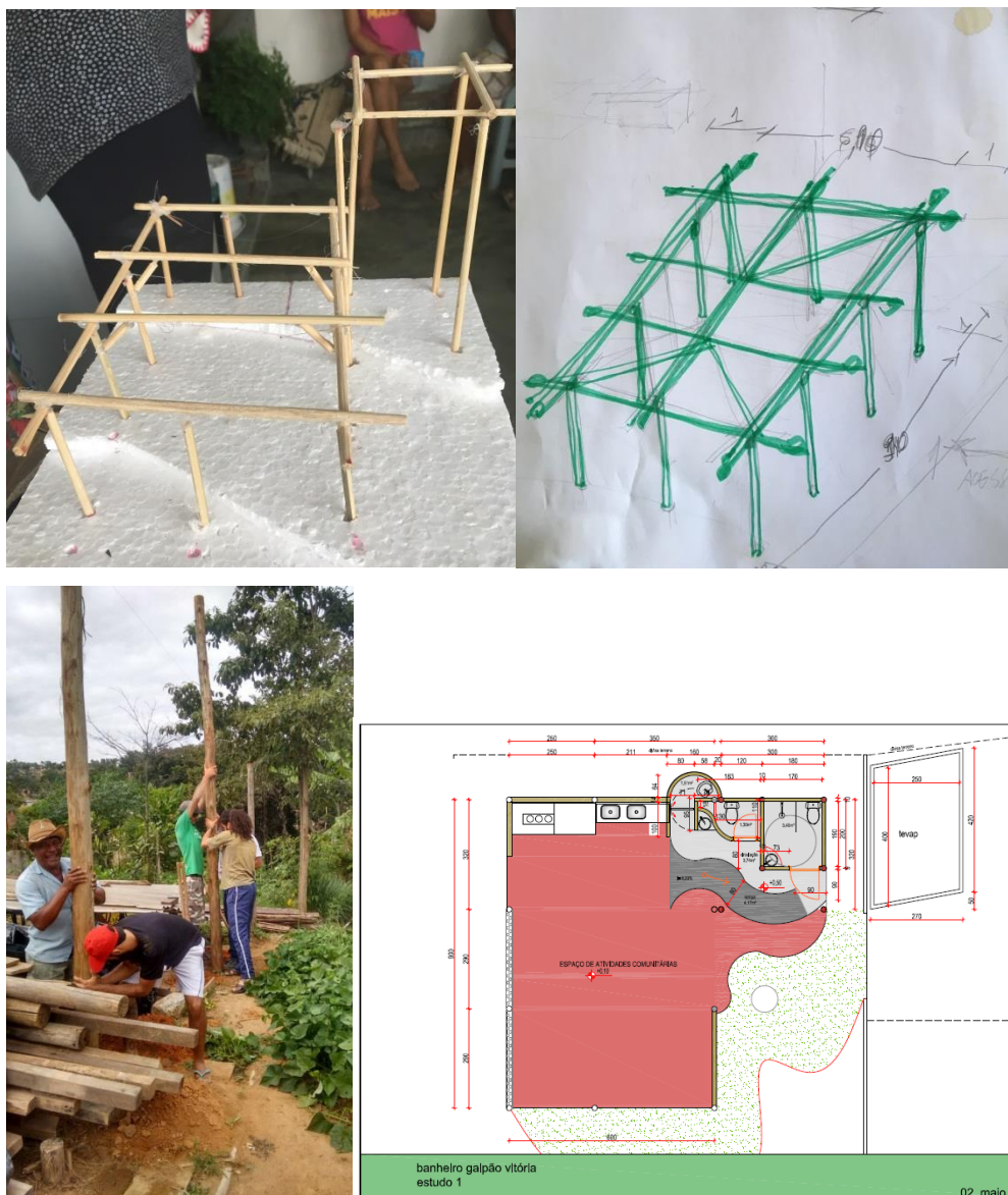
FIGURAS 49, 50, 51,52 – Fotos do processo de concepção, projeto e construção do Galpão Fonte: Izabella Galera (2018).
