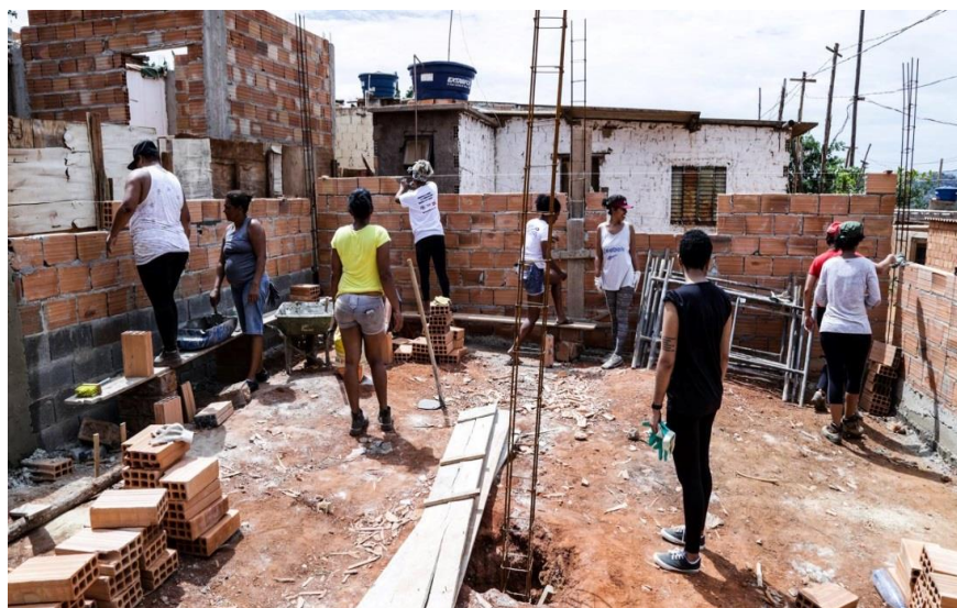
FIGURA 48 – Foto da Oficina de Autoconstrução para Mulheres
