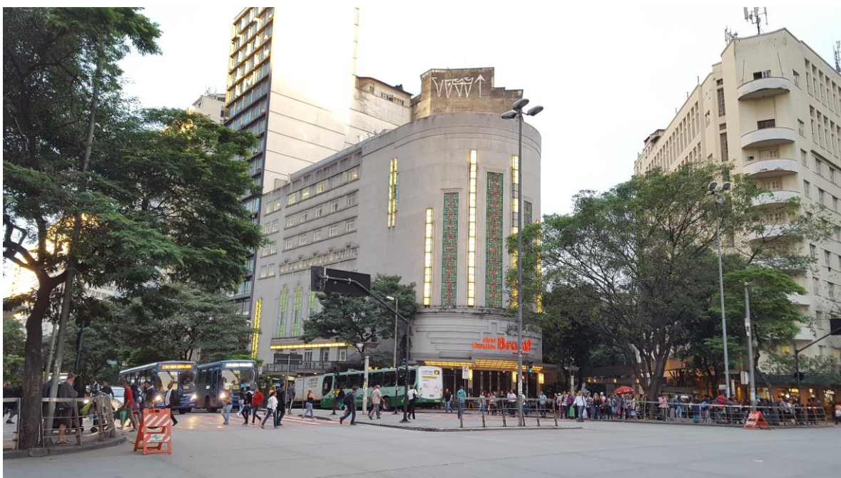
Figura 12: Edifício do Cine Brasil: Ângelo Murgel, 1932.
