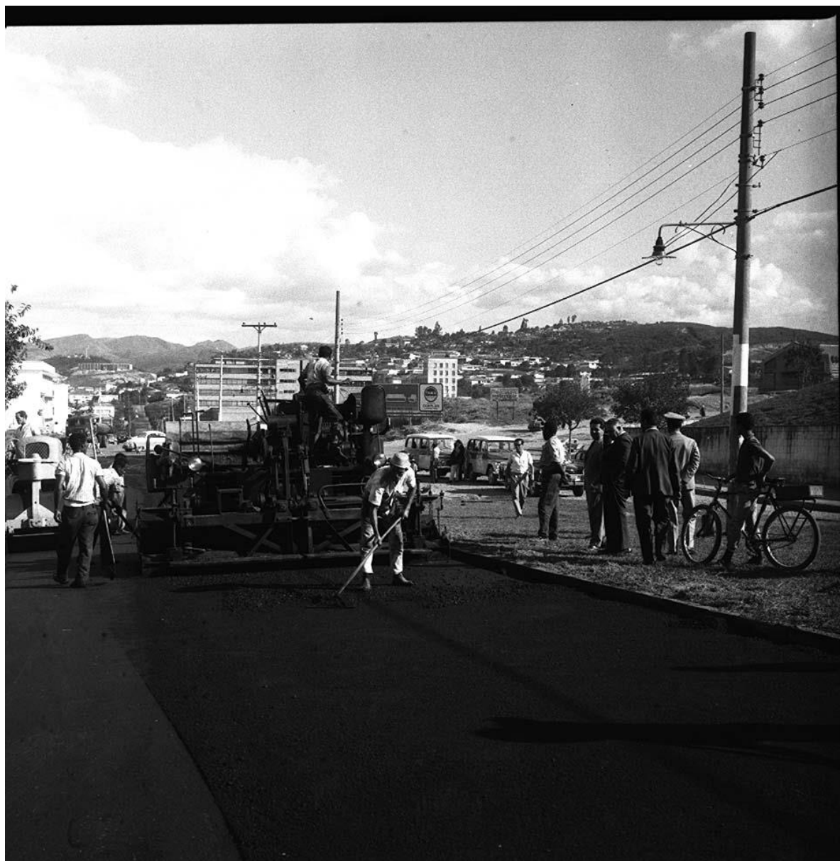
Figura 20: Reasfaltamento da Av. do Contorno com Olegário Maciel, 08 jul. 1966.
