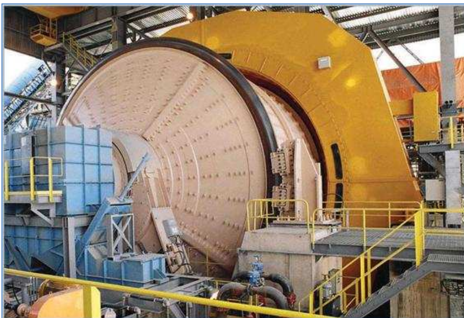
Figura 4.3 - Moinho SAG instalado na Mina de Cobre de Sossego, Pará (Metso, 2005).
