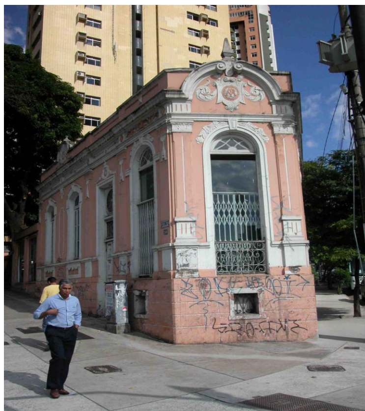
Figura 66 - Manchas de vandalismo – Edificação situada entre a Av. Afonso Pena e Av. Bernardo Monteiro – Belo Horizonte Fonte: Acervo do IEPHA.
