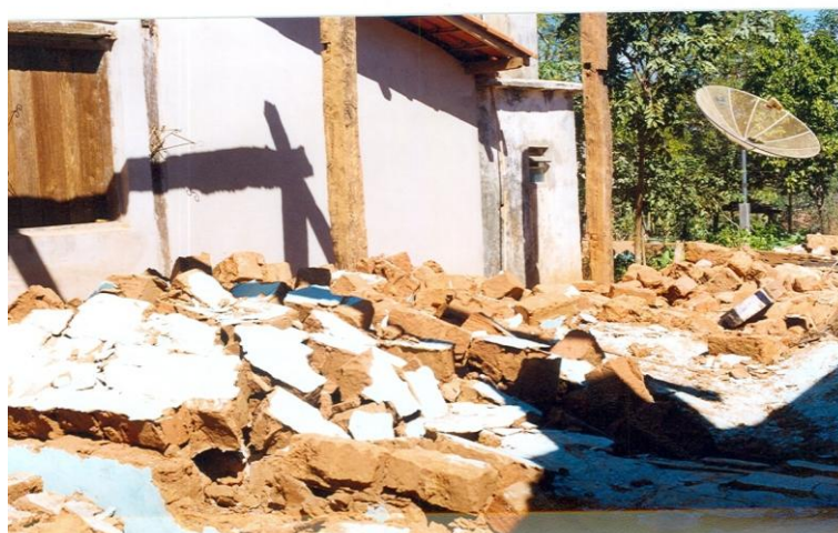
FIGURA 113 - Fotos 113a e 113b: Detalhe e vista parcial de residência demolida; alguns componentes de adobe foram reutilizados na recomposição dos painéis das paredes da capela.
