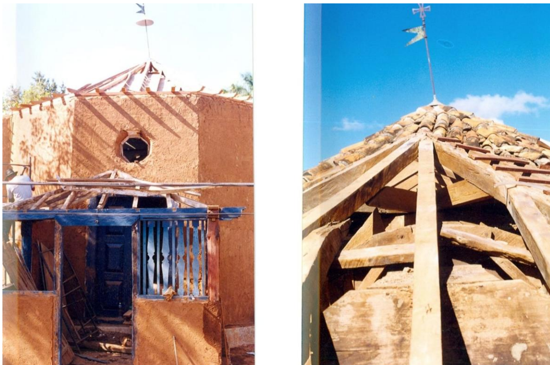
FIGURA 146 - Foto 146a: Vista frontal da capela, após emboçamento da alvenaria de adobe. Vê-se, à direita da foto, o cunhal frontal esquerdo do copiar, peça substituída inteiramente com a utilização de aroeira. Foto 146b: Detalhe da estrutura de madeira do telhado sobre capela-mor, inclusive parte do forro do altar-mor.
