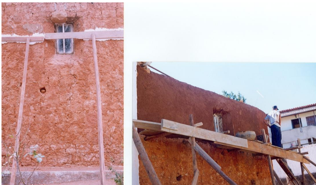
Figura 123 - Fotos 123a e 123b: Parede 8 antes e após o início da aplicação de argamassa de revestimento constituído por terra peneirada, areia média, esterco de boi e água. Após alguns traços experimentais, adotou-se o traço 1:1:2 (em volume).
