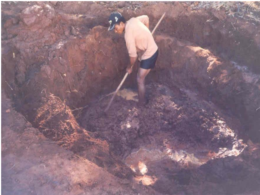
Figura 10 - Preparo da argamassa para confecção dos tijolos Fonte: Acervo do IEPHA.
