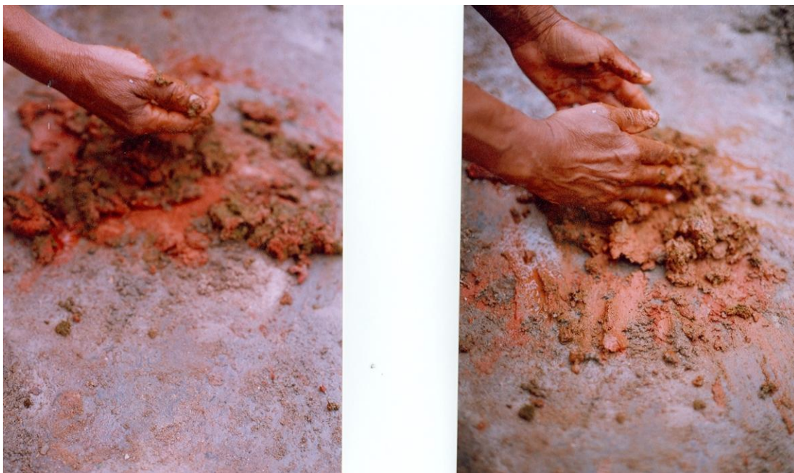
FIGURA 128 - Fotos 47 e 48: Mistura e homogeneização dos constituintes da argamassa – terra, areia e esterco – nas proporções 1:1.
