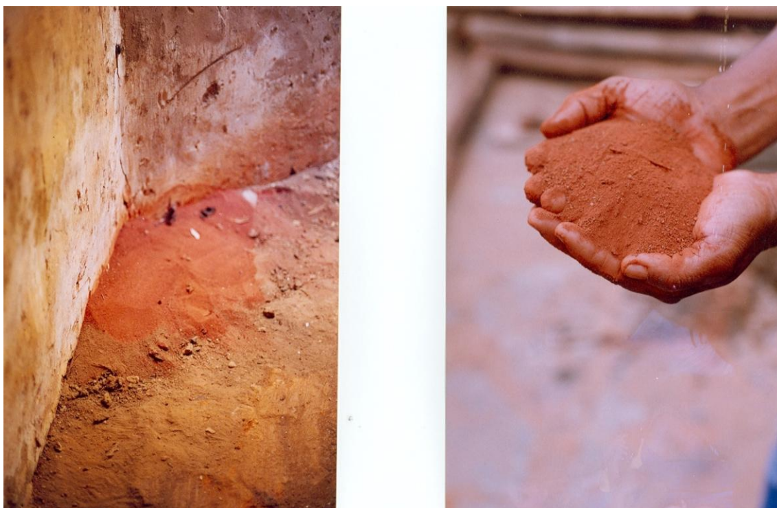
FIGURA 127 - Fotos 127a e 127b: Início do preparo de argamassa de barro e esterco para aplicação de revestimento sobre as paredes de adobe. Para o primeiro traço experimental, utilizou-se terra de formigueiro, livre de impurezas orgânicas, encontradas na própria edificação.
