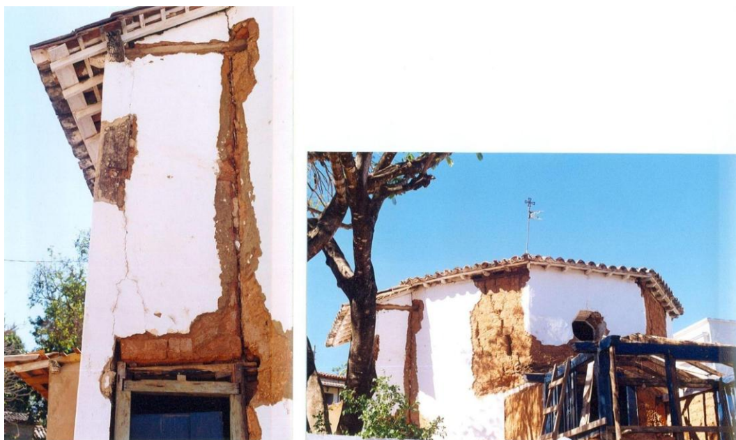
Figura 106 - Fotos 106a e 106b: Detalhe e vista da fachada principal da Capela São José após a demolição do revestimento nas áreas onde este apresentava fissurado. A remoção do reboco evidenciou-se a parede de adobe. No detalhe, observa-se a conformação de junta a prumo na ligação do volume da nave ao volume da torre sineira.
