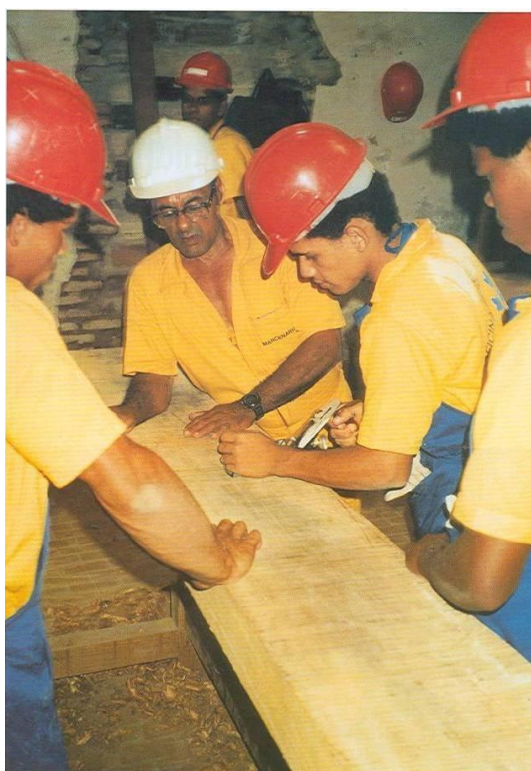
Figura 158 – Ensino para serviços de emendas em madeira
