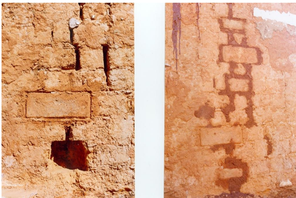
FIGURA 118 - Fotos 118a e 118b: Idem, apresentando a seqüência de introdução de componentes, a cada 2 ou 3 fiadas e o rejuntamento com barro e pedaços de telha cerâmica.
