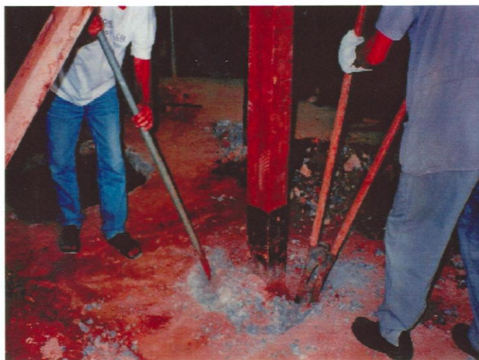
Figura 153 – Foto 153: Prospecção e escavação do terreno para substituição de "pé de esteio", comprometido por sapata isolada de concreto armado Fonte: Acervo do autor.
