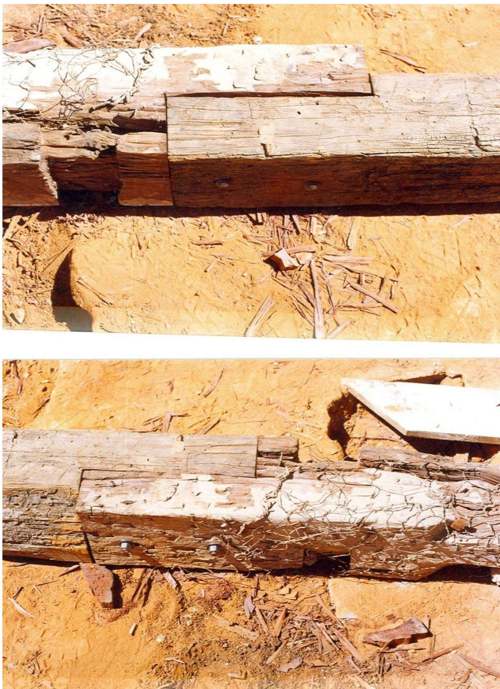
Figura 145 - Fotos 145a e 145b: Execução de emenda em peça de madeira para recuperação do cunhal frontal do copiar. O trecho afetado pela unidade foi retirado e para reposição utilizou-se parte do outro esteio, também de aroeira, provavelmente da demolição de uma residência local.
