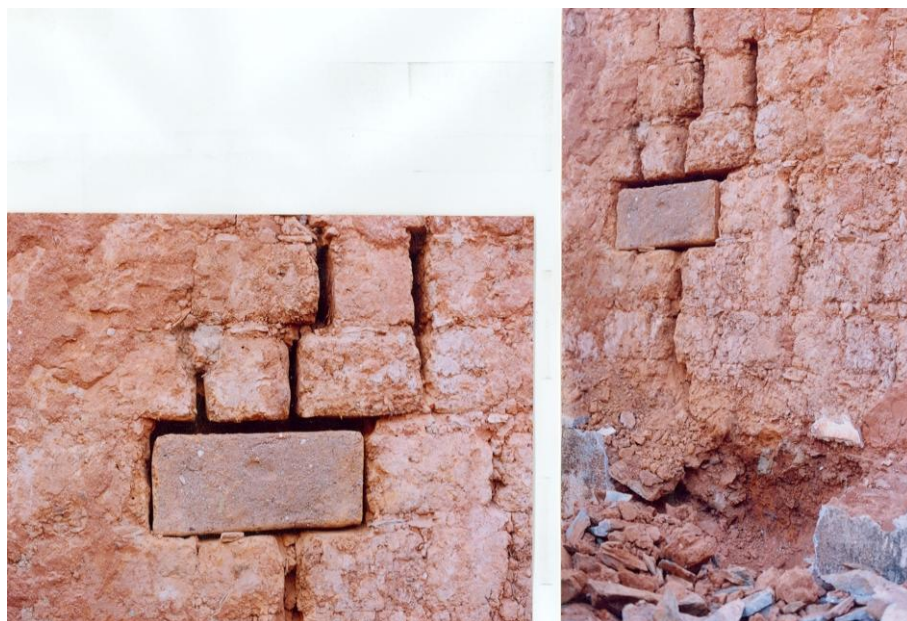
Figura 116 - Fotos 116a e 116b: Detalhe da parede 09 com a introdução de componentes de adobe com dimensões adequadas a execução da “costura” da alvenaria. Da produção de componentes de dimensões de 20x20x60cm foram selecionados aqueles que não apresentaram fissuração por retração inicial ou empenamento.
