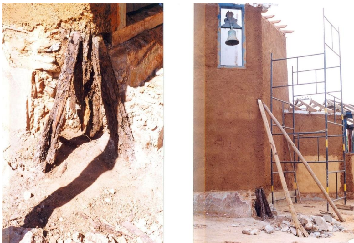
Figura 144 – Fotos 144a e 144b: Vista e detalhe do cunhal de madeira entre as paredes 15 e 16 após o escoramento do esteio para recuperação da estrutura. O tripé de sustentação foi retirado e executado uma emenda na peça, utilizando-se madeira da mesma espécie (aroeira) e de mesma seção.
