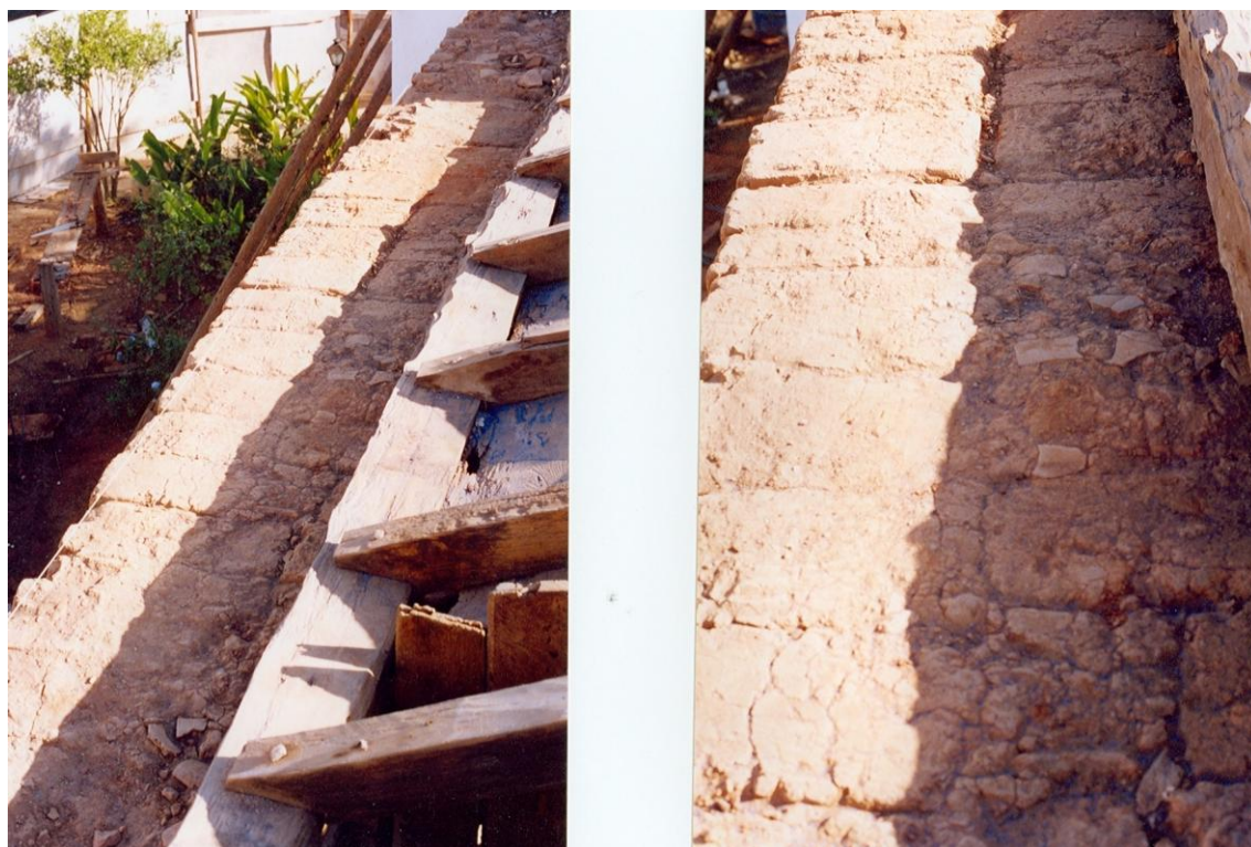
Figura 120 - Fotos 120a e 120b: Detalhe do topo da parede 08, onde observa-se, para última fiada, a consolidação de 2 tijolos atravessados para obtenção de espessura de parede de 60cm. Afiado subsequente apresenta tijolos de 20x20x30cm postos ao cumprido (de cutelo) alternados (com frequência irregular) com tijolos de 20x20x60cm atravessados (de fiação). Como mencionado, a particularidade no encontro das paredes em ângulos de 135° e a pequena extensão das mesmas parece ter dificultado a adoção de um aparelho regular na constituição dos painéis de alvenaria quando da construção das paredes da nave e da capela-mor.
