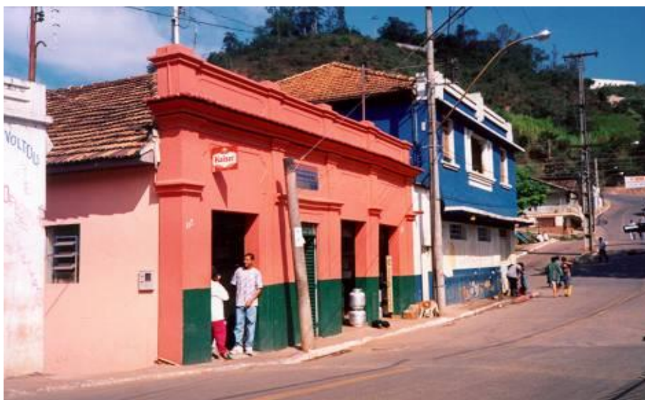
Figura 98 - Casa na Praça da Estação – Raposos/MG Fonte: Acervo do IEPHA.
