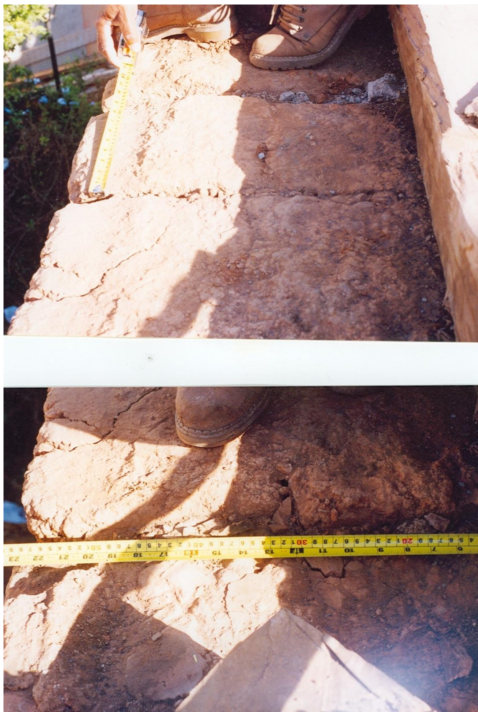
Figura 121 - Fotos 121a e 121b: Detalhe do topo da parede 09, onde empregou-se tijolos colocados atravessados, mas com comprimento de 60cm, em toda a extensão da fiada.
