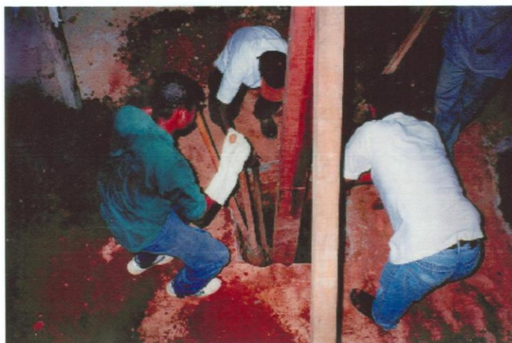
Figura 154 – Foto 154: Prospecção e escavação do terreno para substituição de "pé de esteio", comprometido por sapata isolada de concreto armado Fonte: Acervo do autor.
