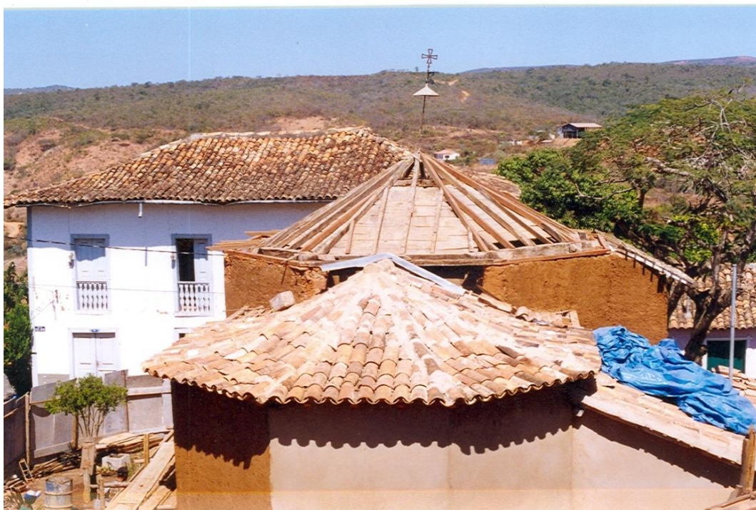
Figura 140 - Fotos 140a e 140b: Vista da cobertura da capela, durante serviço de entelhamento da capela-mor e a recuperação da estrutura de madeira da nave.
