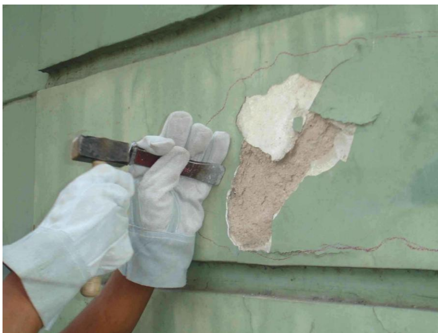
Figura 73 - Extração de amostras em áreas menos degradadas das fachadas com ferramentas adequadas Fonte: Acervo do autor.
