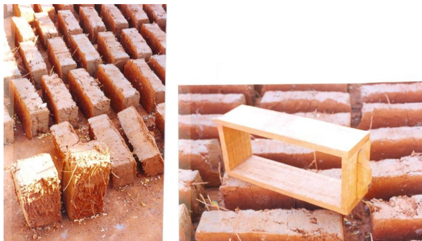
FIGURA 114 - Fotos 114a e 114b: Componentes de adobe fabricados sobre encomenda para utilização na capela de São José e forma de madeira empregada. Observa-se, pela má qualidade dos componentes, a ausência de domínio da técnica e/ ou a inobservância dos procedimentos adequados para sua produção, como pó exemplo: parte de secagem desnivelado, homogeneização insuficiente da mistura e comprimento excessivo das fibras.
