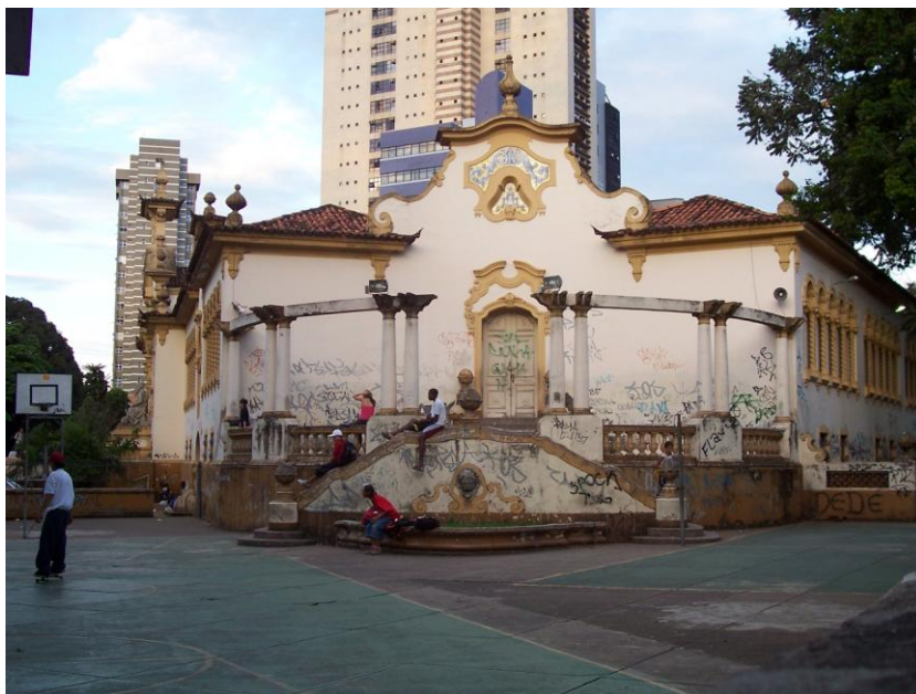
Figura 65 - Manchas de vandalismo Escola Pedro II – Belo Horizonte Fonte: Acervo do IEPHA.
