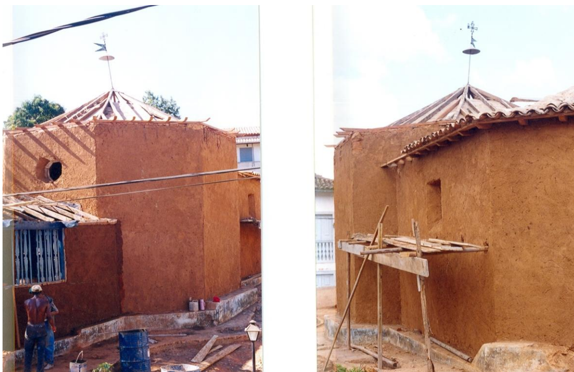
Figura 138 - Fotos 138a e 138b: Vista lateral esquerda da capela após aplicação do emboço.
