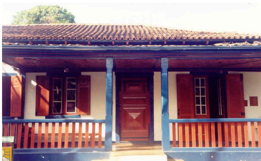
Figura 97 - Fachada Principal – Santa Luiza Fonte: Acervo do IEPHA.
