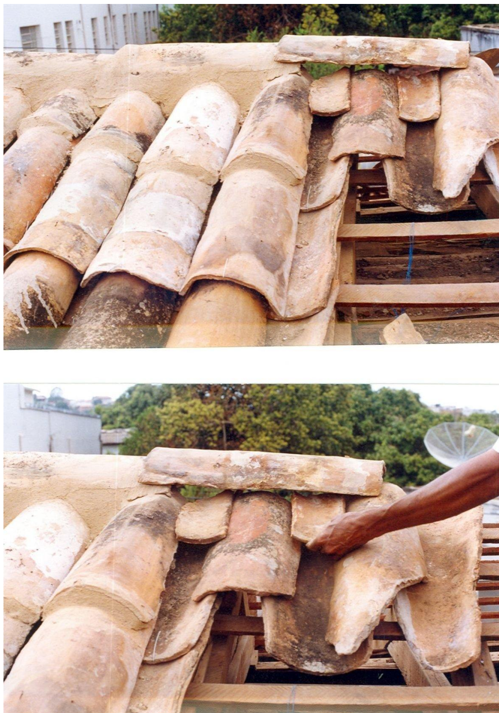
Figura 150 - Fotos 150a e 150b: Arranjo de telhas, com a introdução de “cacos” de telhas nos interstícios formados entre 2 capas recomendado para a redução do volume da argamassa empregada para o embocamento da cumeeira. Esse procedimento, ao reduzir a espessura da argamassa, reduz a possibilidade da fissuração da mesma garantindo melhor estanqueidade do telhado.
