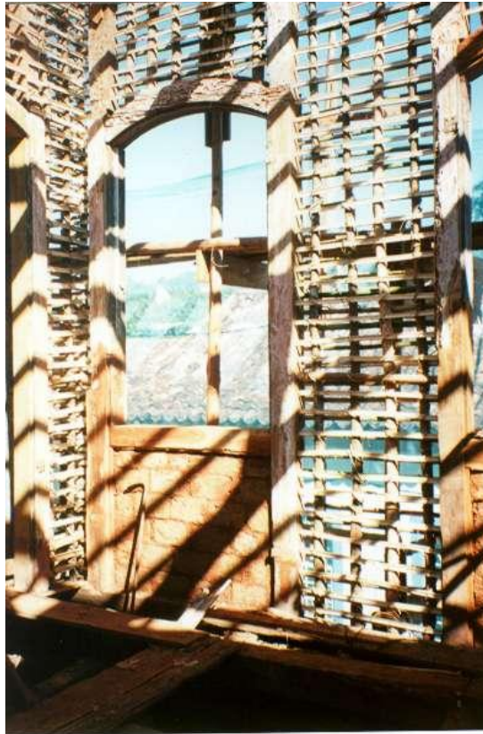
Figura 16 - Tiradentes – Sobrado quatro cantos – armação da estrutura em pau-a-pique Fonte: Acervo do IEPHA.
