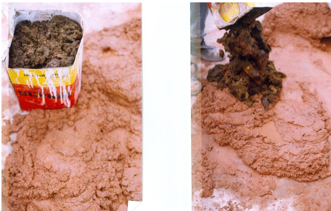
Figura 130 - Fotos 130a e 130b: Preparo de argamassa em maior quantidade, após sucessivos ajustes na dosagem experimental, adotou-se o traço 2:2:2:1 terra, areia, esterco para o emboço interno e externo. Não foi possível emprego da terra de formigueiro, pela dificuldade de obtenção nas quantidades necessária para toda a igreja.
